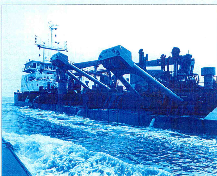
Figuur 1: Baggerwerkzaamheden in de Westerschelde (bron: beoordeling van de effecten van de verdieping 48'-43')
