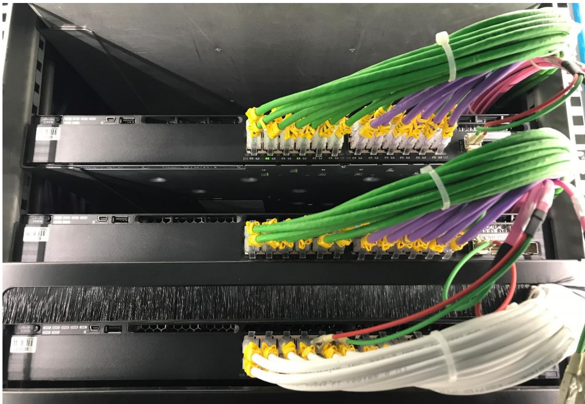
Figura 56: Ejemplo de instalación de 3 switches para redes DANTE primario y secundario y Ethernet (superior, intermedio e inferior respectivamente)
