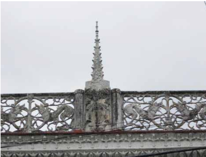
Figura N° 7. Detalle del pretil con pináculo. Fuente: Colección de la Autora.
