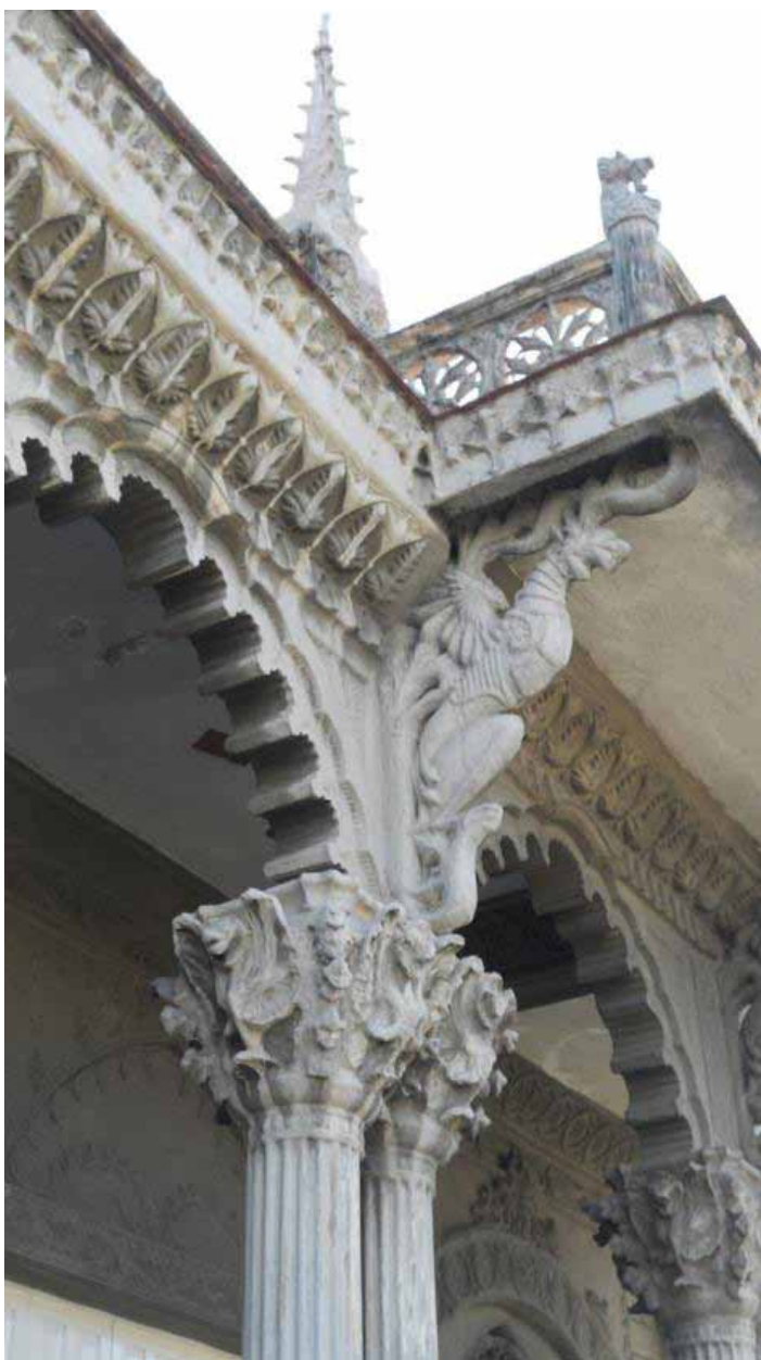
Figura N°5. Detalle de la fachada principal donde se aprecian varios elementos decorativos: arco lobulado, capiteles, dragón, motivos fitomórficos, pináculo, etc. Fuente: Colección de la Autora.
