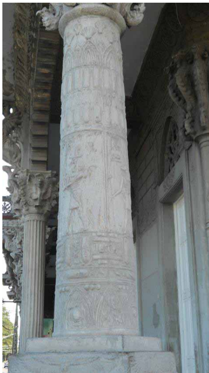
Figura N°6. Columna egipcia de la fachada. Fuente: Colección de la Autora.
