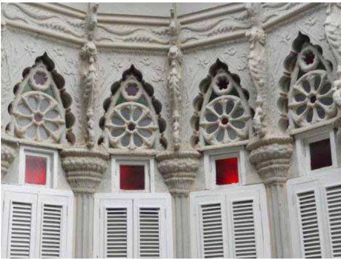
Figura N° 8. Detalle de una de las paredes que rodean el patio, donde se aprecian: otro diseño de arcos lobulados, las columnas adosadas al muro y nuevamente los hipocampos. Fuente: Colección de la Autora.
