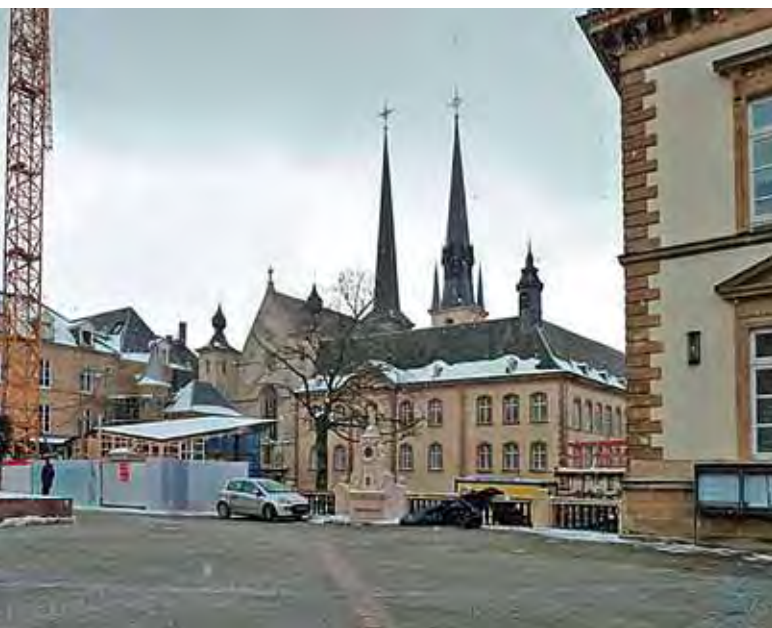
Abb. 5: Das Rathaus (rechts) und das neue Bürgerzentrum werden durch einen Glasgang miteinander verbunden
