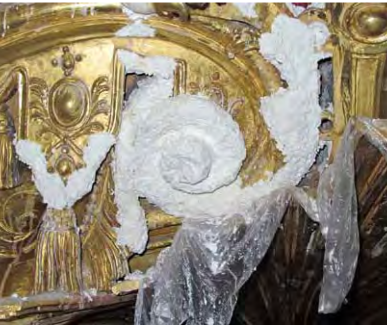
Abb. 6: Kompressenbeschichtung, um Reste oberflächennaher Magnesiumsulfate möglichst zu extrahieren bzw. zu neutralisieren (Foto: M. Staschull, 2010)
