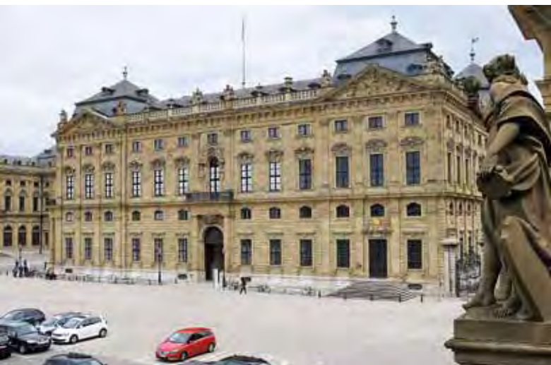
Abb. 1: Südkomplex der Würzburger Residenz mit Stufenportal zur Hofkirche auf der Westseite (Foto: M. Staschull, 2013)
