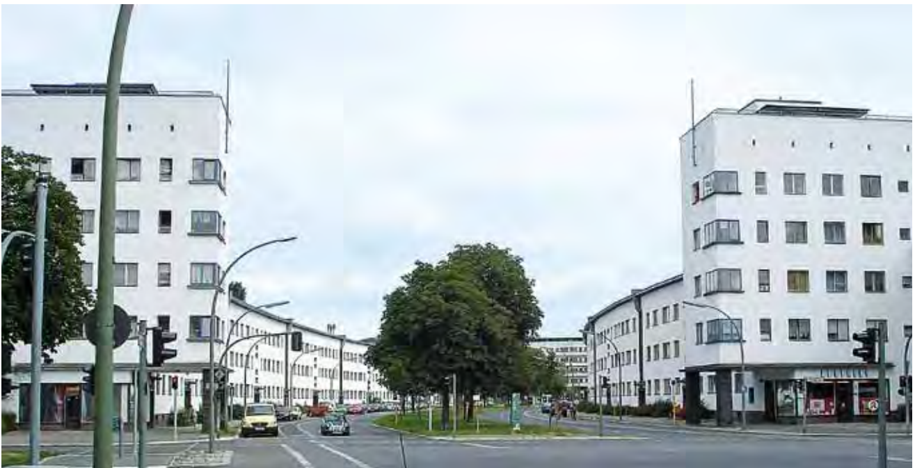
Abb. 35: Der Eingang zur Arosier Allee mit den Turmhäusern. Der Mittelstreifen noch mit zu dichter und zu hoher Vegetation
