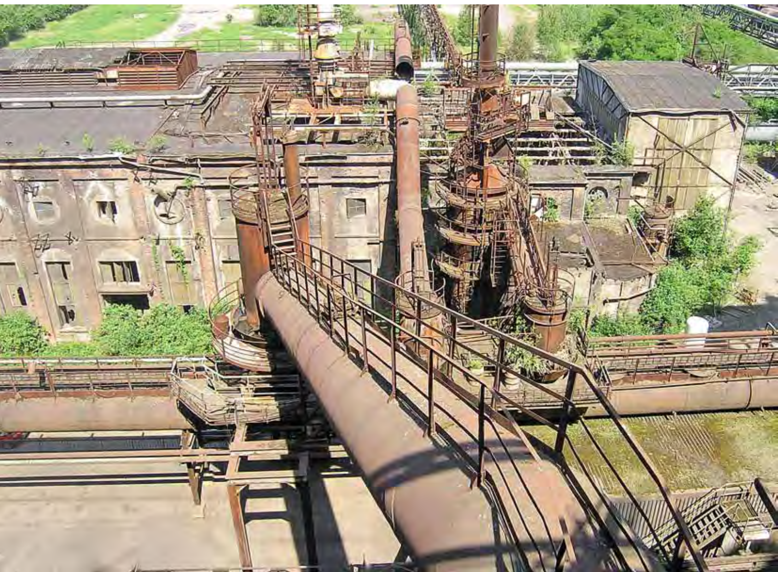
Abb. 4: Kraftwerk 1, teileingestürzt, Situation ca. 2007
