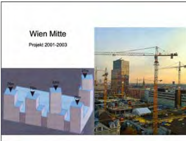
Einer der fünf geplanten Türme wurde gebaut. Anstoß für das Wiener Memorandum 2005
