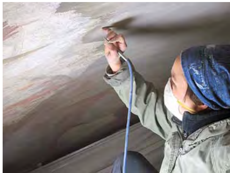
Abb. 12: Westkuppel mit grauer Überfassung, die mittels Mikrostrahlverfahren abgenommen werden konnte (Foto: M. Staschull, 2012)
