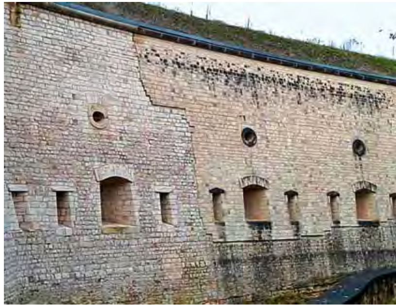
Abb. 1: Fort Thüngen, links originales Mauerwerk, rechts Ergänzung nach den erhaltenen Plänen
