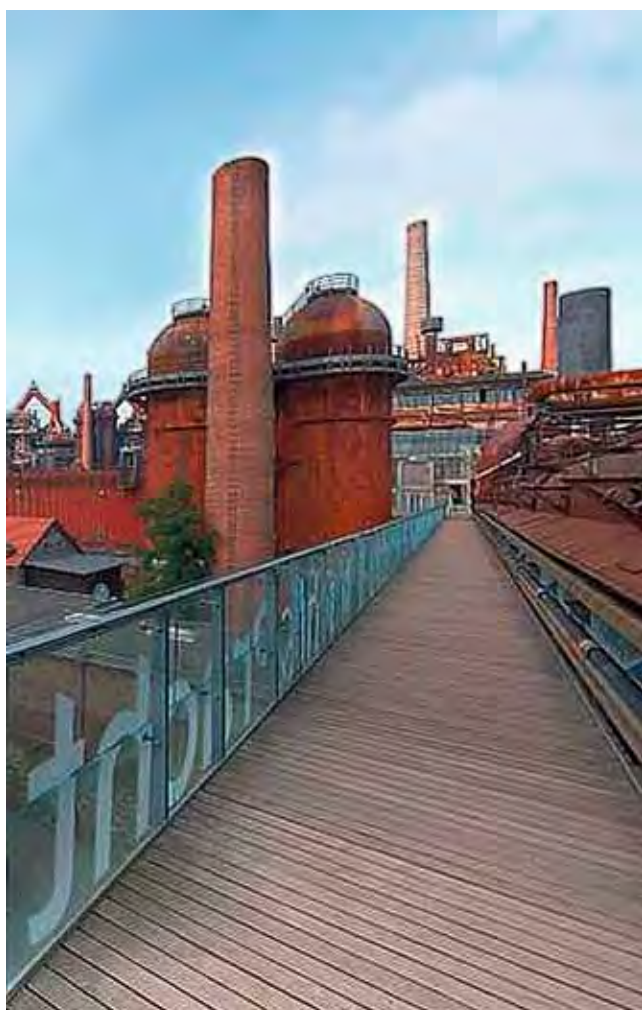
Abb. 1: Rohrbrücke mit Gichtgasleitung und Windleitungen als Verbindung zwischen dem Gasgebläsehaus und den Hochöfen, Werbung auf der Internetseite des Welterbes
