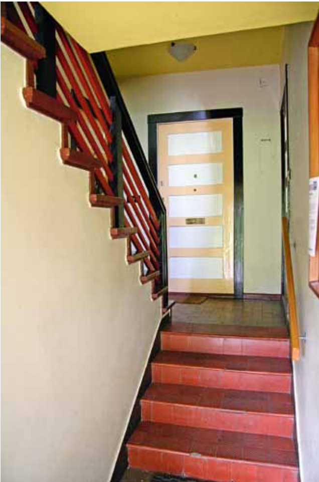
Abb. 9: Das Treppenhaus nach der Instandsetzung
