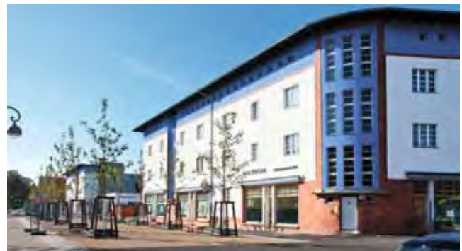
Abb. 19: Das Vorgelände der Siedlung zur Fritz-Reuter-Straße nach dem „Aufräumen“
