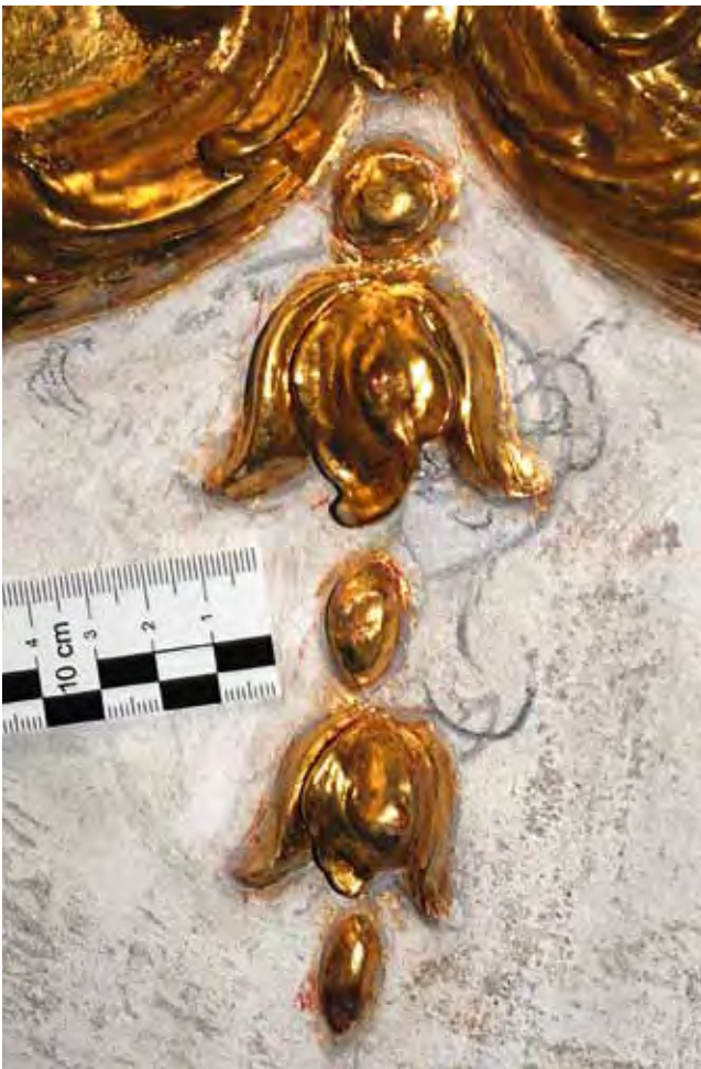
Abb. 4: Stuckdekoration mit freigelegter Vorzeichnung auf dem Wand- und Gewölbeputz (Foto: M. Staschull, 2010)
