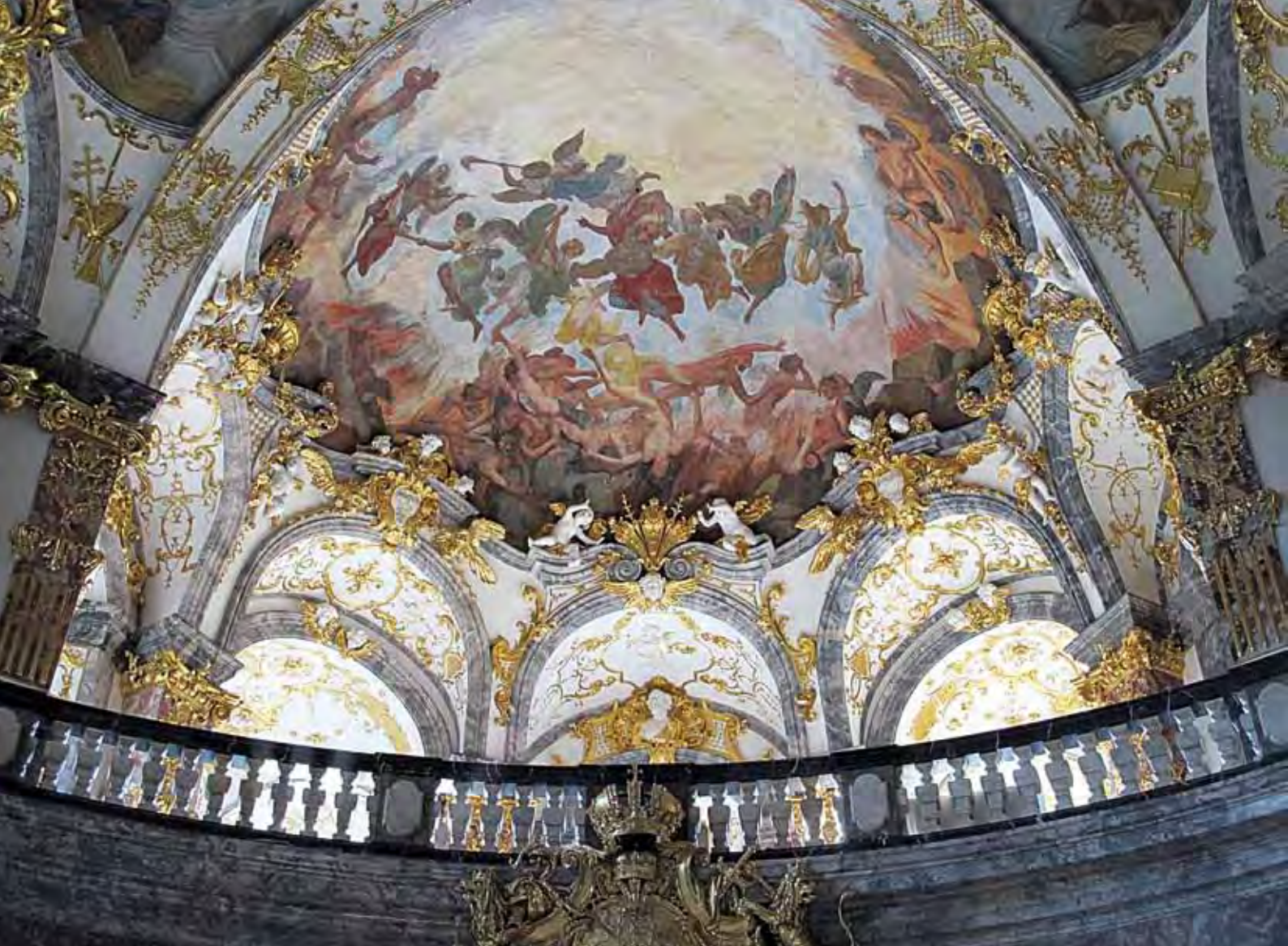
Abb. 13: Westbereich der Hofkirche mit freigelegter und retuschierte Gewölbemalerei (Foto: M. Staschull, 2012)
