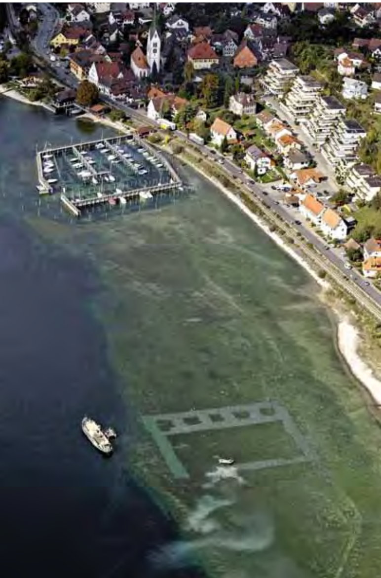
Abb. 4: Sipplingen-Osthafen, Sipplingen. Der Einbau von Kies als Erosionsschutz in der Flachwasserzone verhindert die weitere Abspülung von Kulturschicht. Hier wird ein wabenförmiger Erosionsschutz von Forschungstauchern des Landesamts für Denkmalpflege eingebracht
