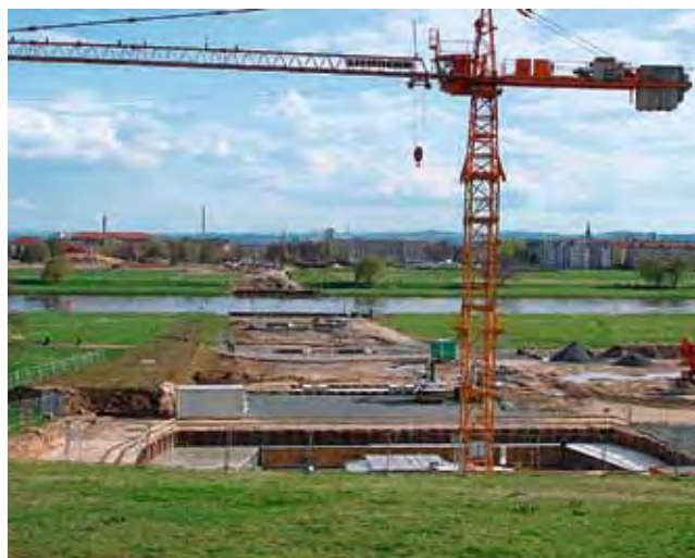
Abb. 2: Bau der Waldschlösschenbrücke in Dresden (April 2009)
