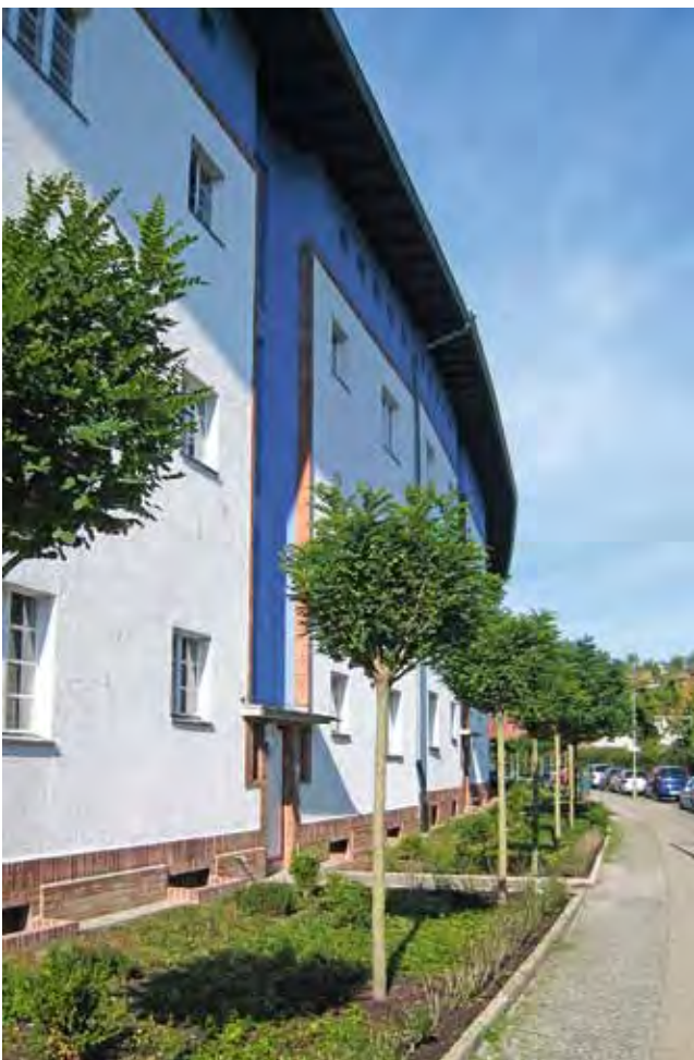
Abb. 2: Wohnen im Welterbe – Verbesserung des Wohnumfelds in der Hufeisensiedlung in Berlin
