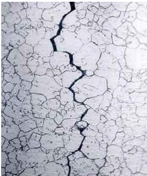
Obr. 158 Koroze za napětí
