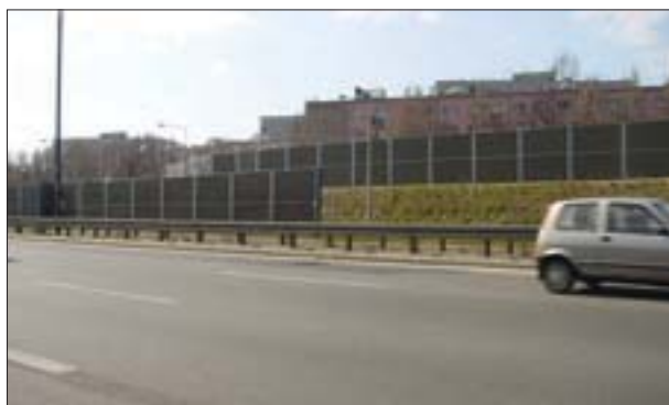
Rys. 16.6.3. Ekran akustyczny w Warszawie mieszczący się w Al. Armii Krajowej. Autor R. J. Kucharski.
