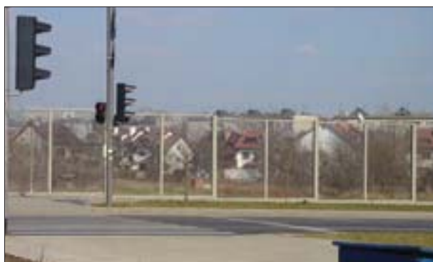
Rys. 16.6.4. Ekran akustyczny w Warszawie mieszczący się w Al. Armii Krajowej. Autor R. J. Kucharski.
