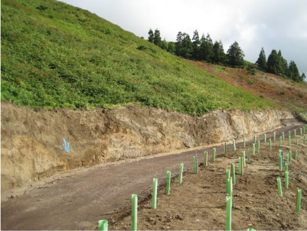
Fotografia 3: Abertura de caminhos
