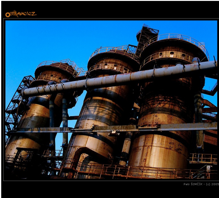
Obr.5.4 Cowperovy ohříváče
