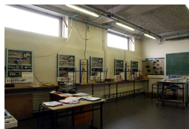
Second espace réservé à l'étude des branchements électriques Phot. Catherine Guégan IVR82_20116901938NUCA
