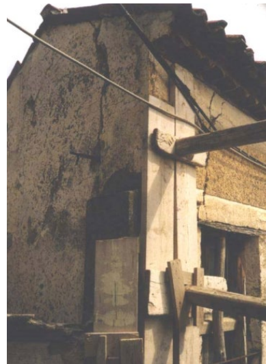
Figura 24: Ejemplos de afectaciones Moderadas en edificaciones de mampostería (Continúa)
