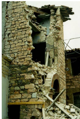
Figura 26: Ejemplos de afectaciones Severas en edificaciones de mampostería
