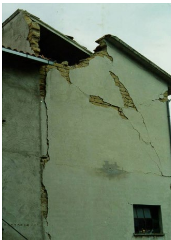
Figura 23: Ejemplos de afectaciones leves o existentes en edificaciones de mampostería
