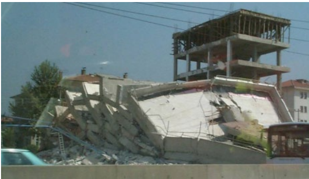
Figura 28: Ejemplos de afectaciones Severas en edificaciones de concreto reforzado
