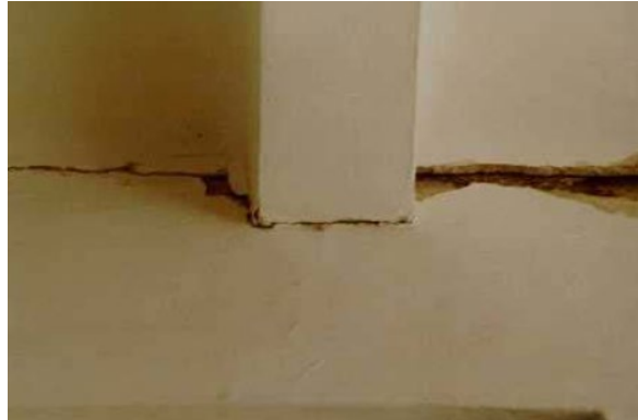
Figura 25: Ejemplos de afectaciones Moderadas en edificaciones de mampostería (Continuación)
