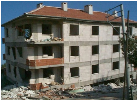
Figura 28: Ejemplos de afectaciones Severas en edificaciones de concreto reforzado
