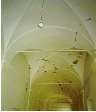
Figura 25: Ejemplos de afectaciones Moderadas en edificaciones de mampostería (Continuación)
