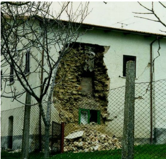
Figura 24: Ejemplos de afectaciones Moderadas en edificaciones de mampostería (Continúa)
