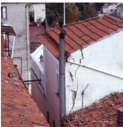
Figura 26: Ejemplos de afectaciones Severas en edificaciones de mampostería
