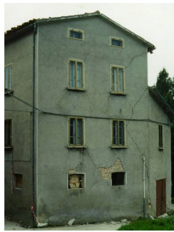
Figura 23: Ejemplos de afectaciones leves o existentes en edificaciones de mampostería
