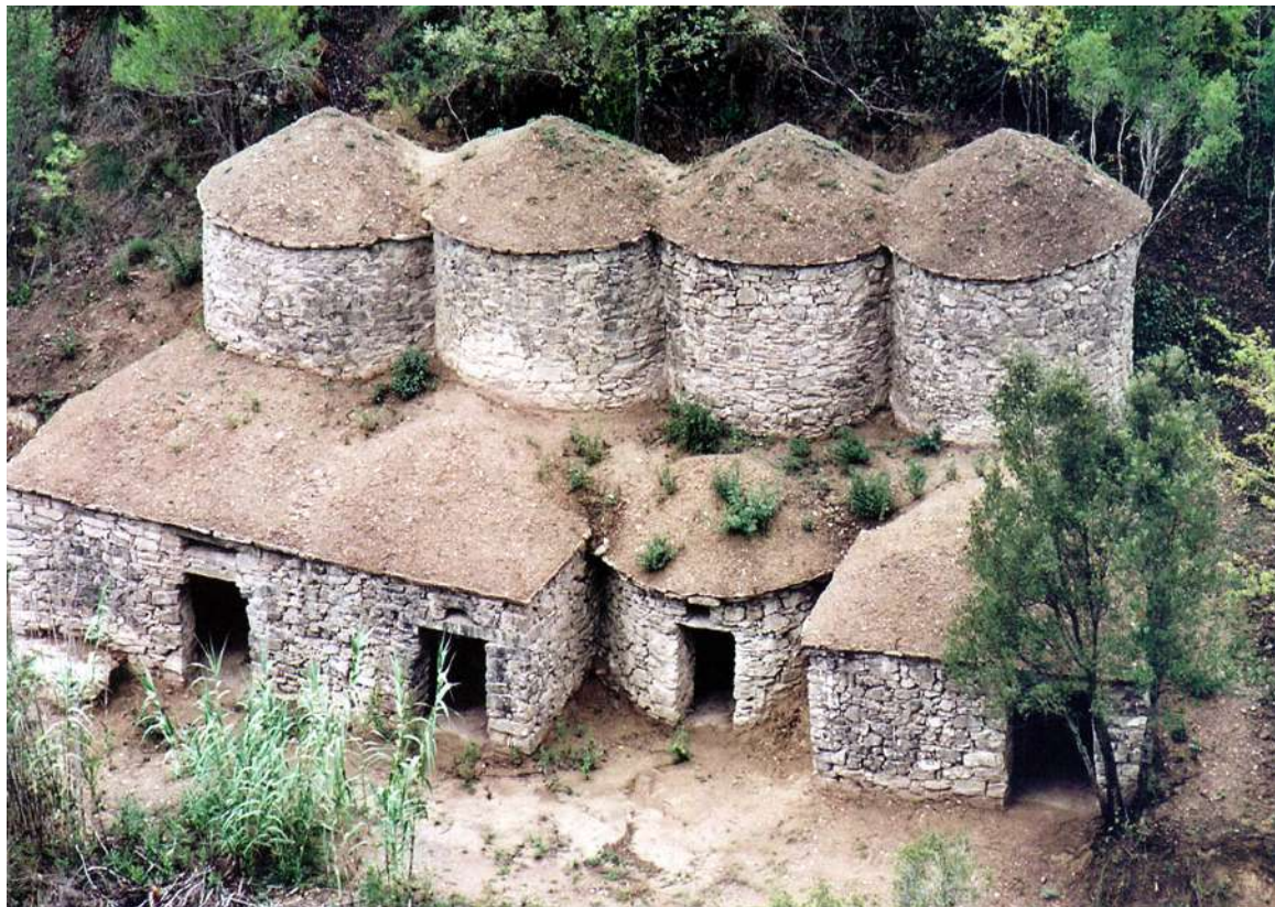
Tines i barraques restaurades (Pont de Vilumara i Rocafort)
