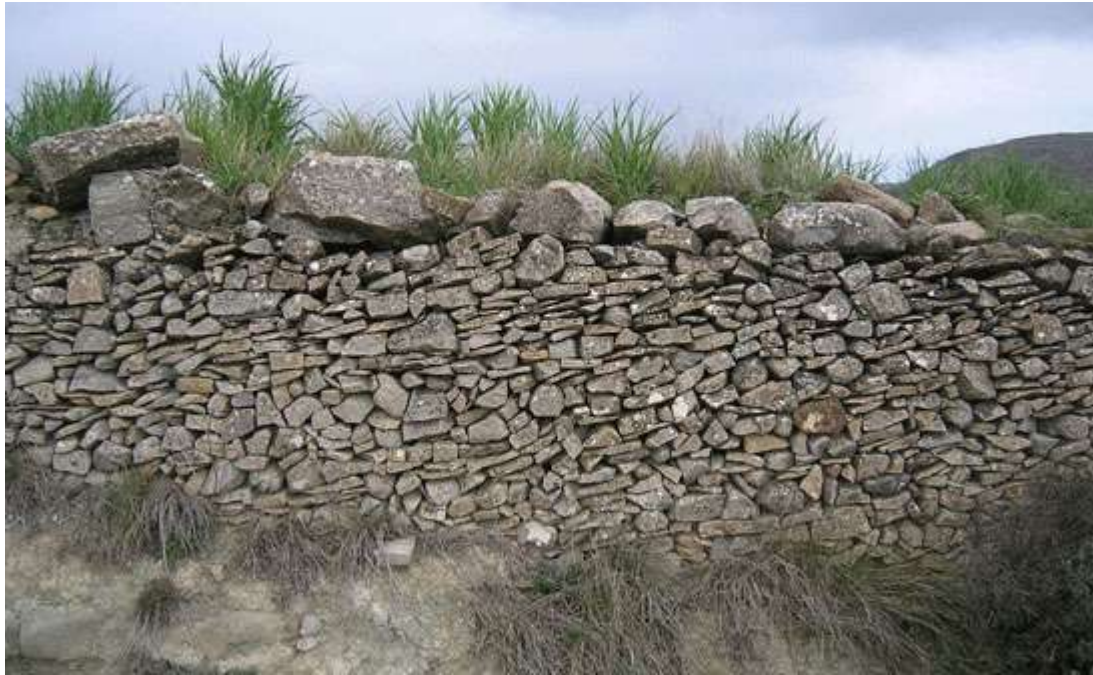
Marge de pedra seca fet amb blocs irregulars petits i coronat amb blocs grans (Sant Mateu de Bages)
