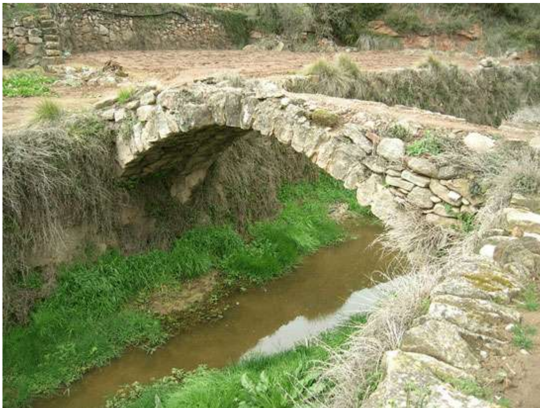
Pont de pedra. Camps (Fonollosa)
