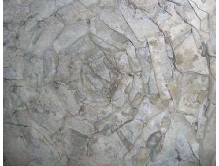
Sistema de cobriment en anells concèntrics
