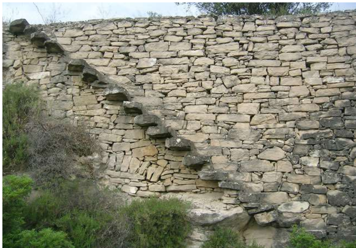
Marge de pedra seca amb escales inserides de més de 6 metres d'alçada (Manresa)
