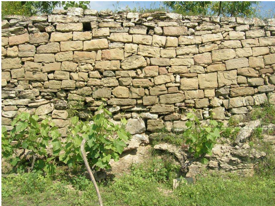
Blocs de pedra molt ben escairats i disposats de forma gairebé lineal (Sant Fruitós de Bages)
