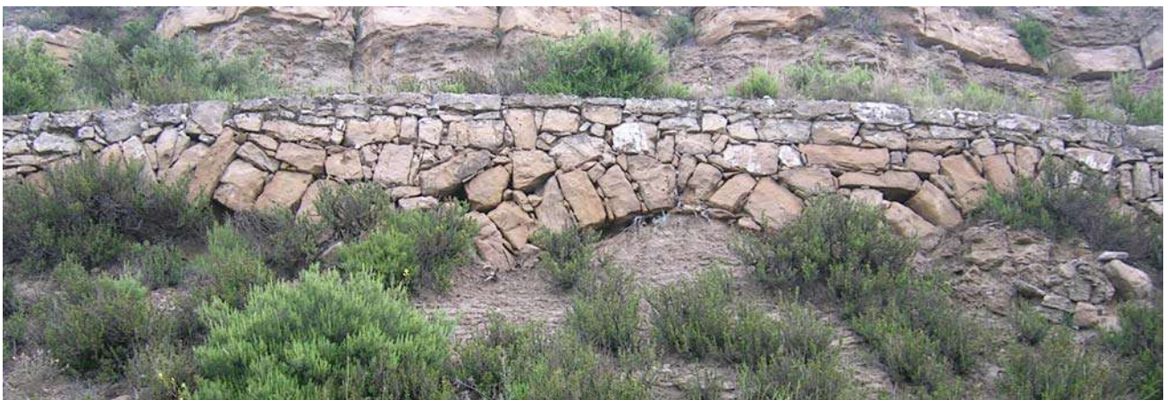
Mur de pedra seca amb base feta en arcs (Manresa)
