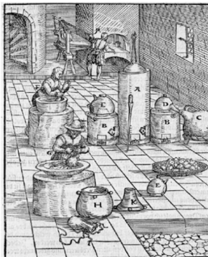
Εικόνα 13: Εξευγενισμός χρυσού με υδράργυρο 61
