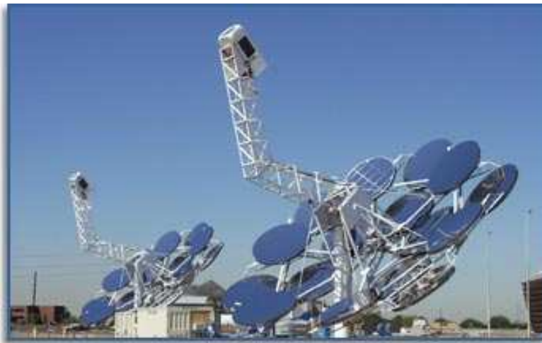
Figure 2.32 : Seconde génération du système Sundish à Tempe en Arizona
