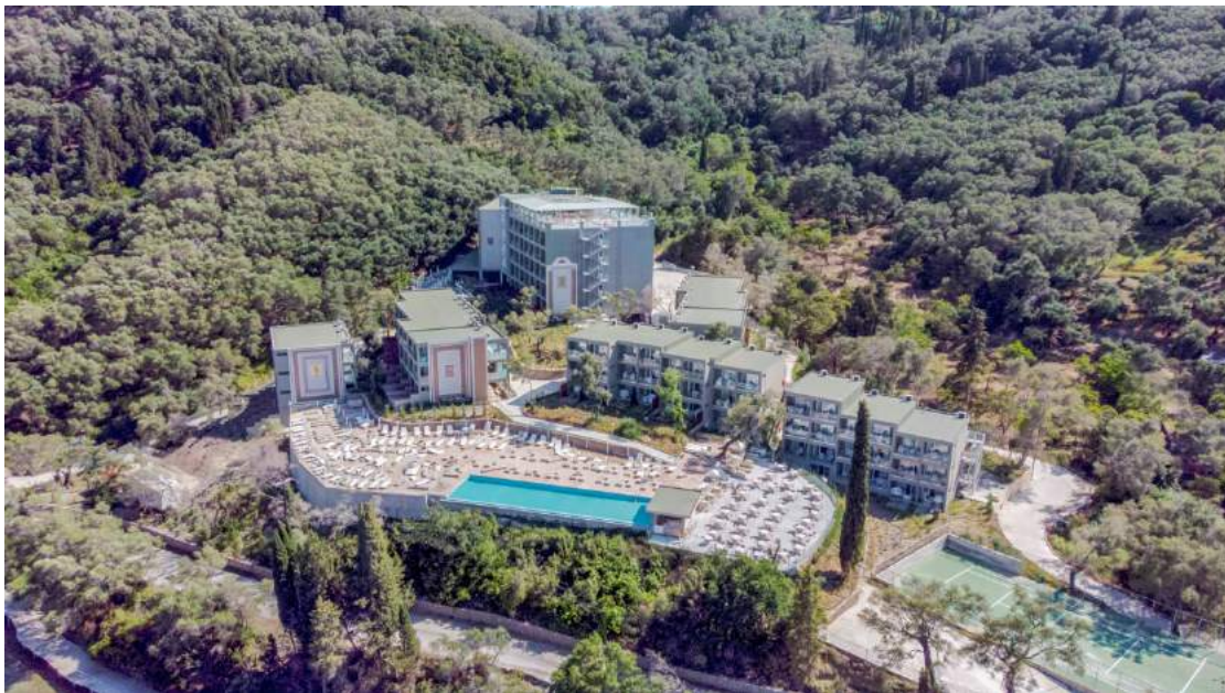
Φωτ. 4 Άποψη των κτηριακών εγκαταστάσεων (ημερομηνία λήψης Ιούλιος 2020)
