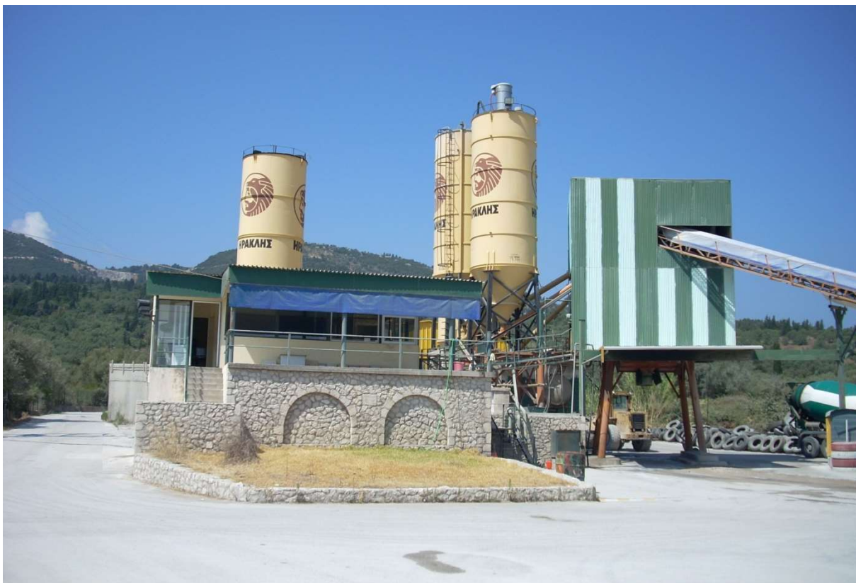
Φ1: Άποψη των εγκαταστάσεων και περιμετρικής βλάστησης στα Δκά όρια του χώρου, από τα Ακά.
