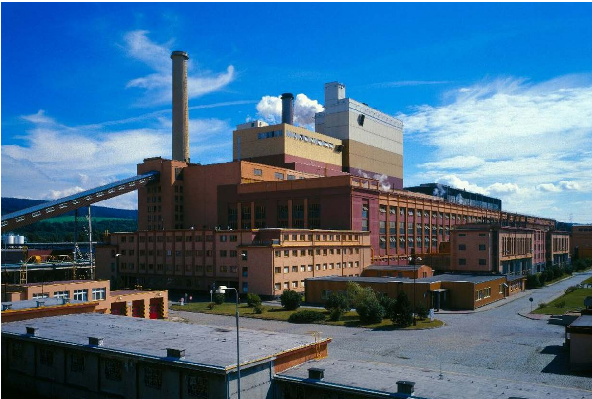
Obrázek 8 Pohled na Elektrárnu Tisová
