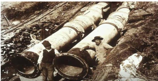
(Fig. 2). Construcció de la canonada.
