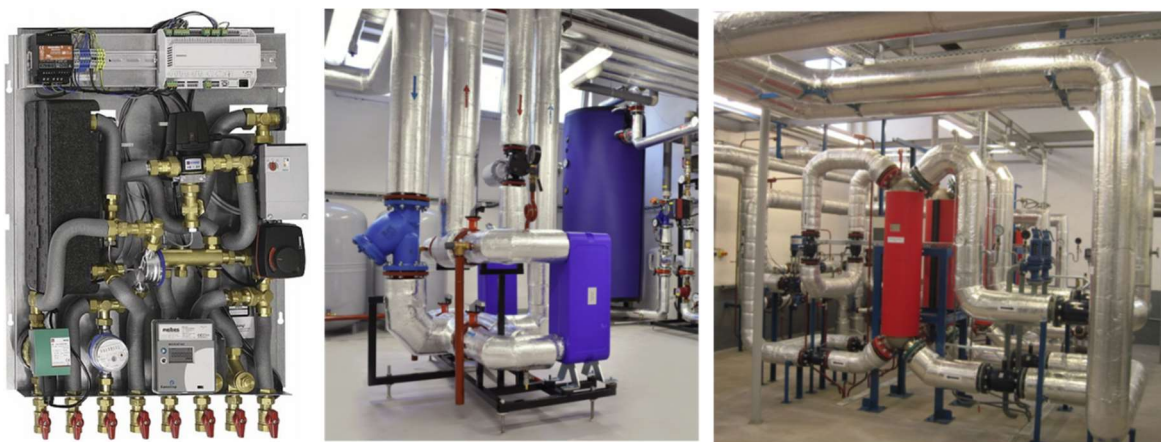
Obrázek 59: Předávací a odběratelské stanice tepla ze SZTE
