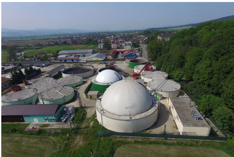
Obrázek 57: Pohled na bioplynovou stanici
