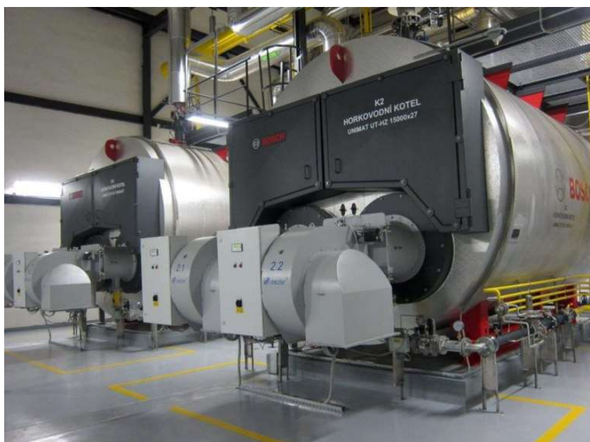
Obrázek 34: Typové provedení středních horkovodních kotlů na zemní plyn
