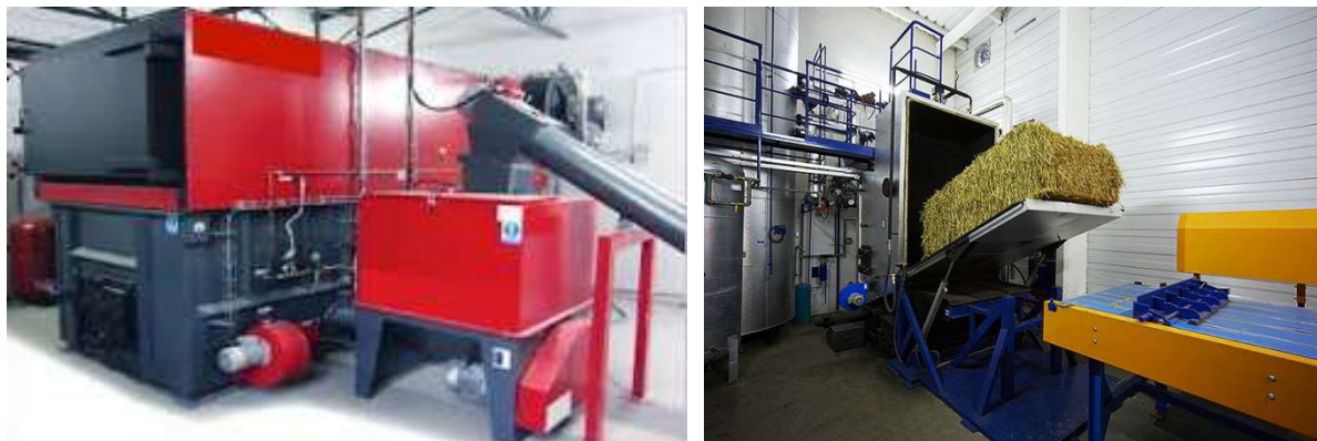
Obrázek 37: Kotle středního výkonu na spalování štěpky a slámy
