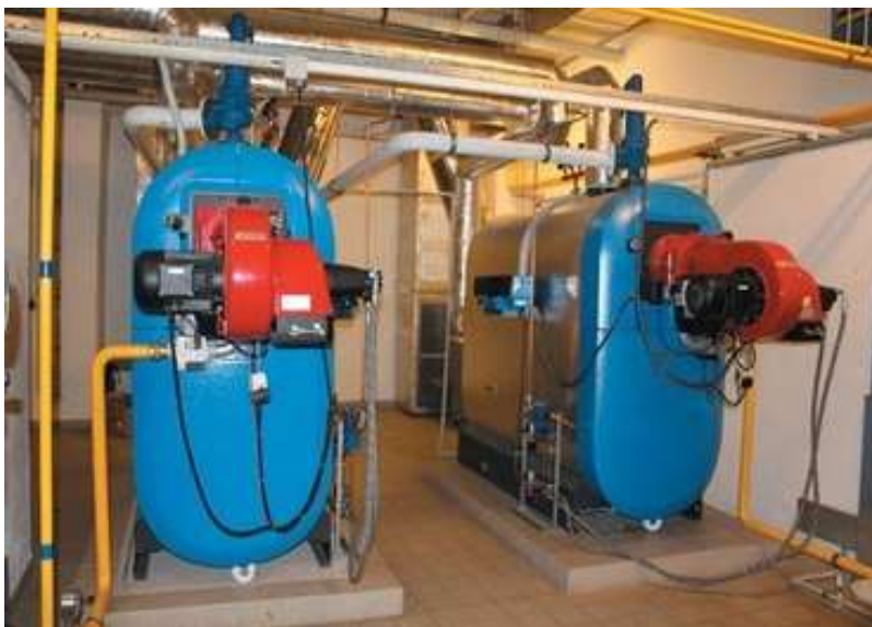
Obrázek 35: Typové provedení menších kondenzačních kotlů na zemní plyn
