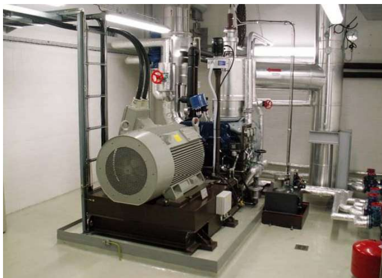
Obrázek 43: Točivá redukce páry
