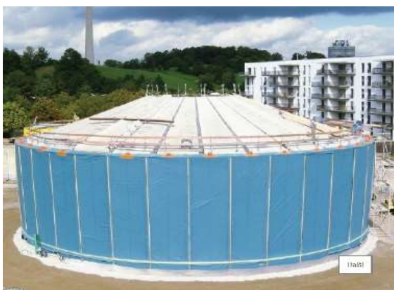
Obrázek 51: Možné provedení statických akumulátorů tepla
