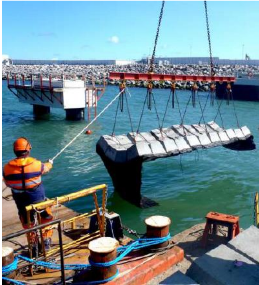
Figura 31. Izaje y colocación de subcapa artificial.
