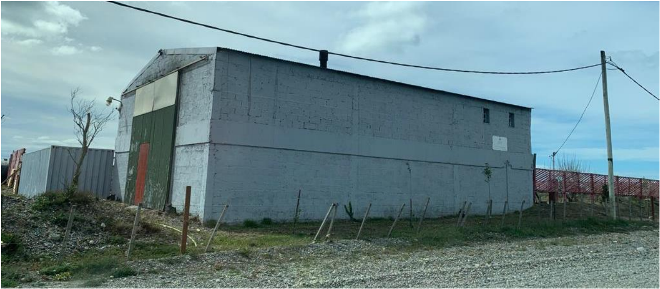
Figura 125. Planta de Tratamiento de Residuos GEO Servicios Ambientales S.R.L. Noviembre 2022.
