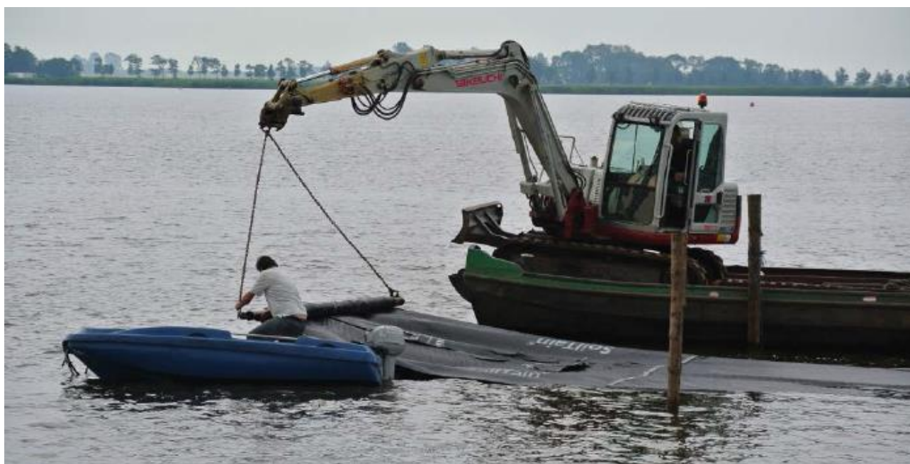
Figura 12. Embarcación de apoyo para extendido del geotubo. Fuente: Huesker.
