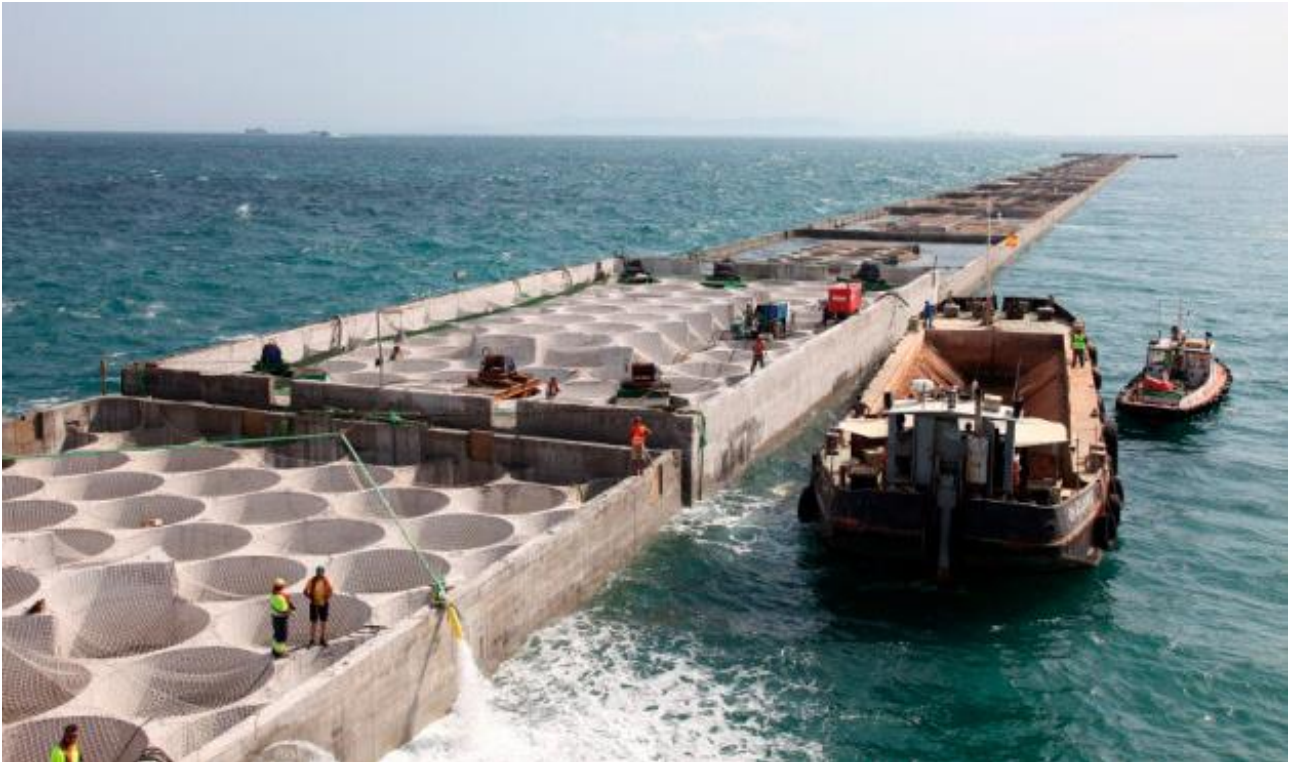
Figura 7. Obra de abrigo de paramento vertical – cajones de hormigón.
