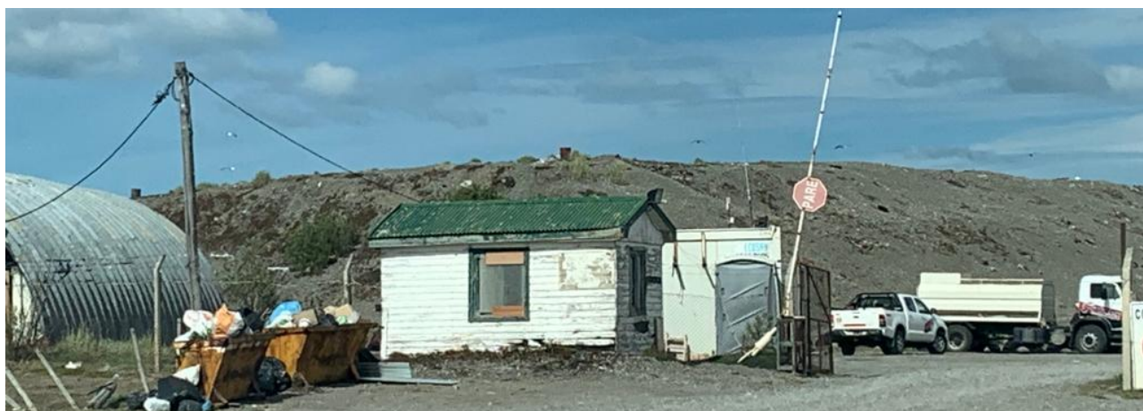
Figura 124. Relleno Sanitario de la ciudad de Río Grande concesionado por Estancia Violetas S.R.L. Noviembre 2022.
