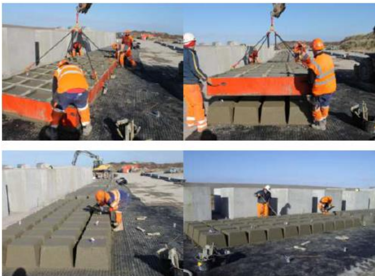
Figura 30. Fabricación de subcapa artificial a pie de obra.
