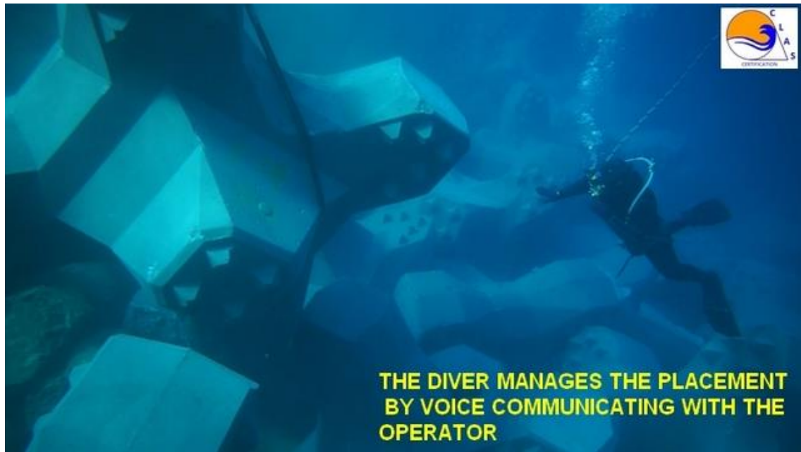
Figura 34. Verificación sub-acuática de colocación del acrópodo. Fuente: Clas certification.
