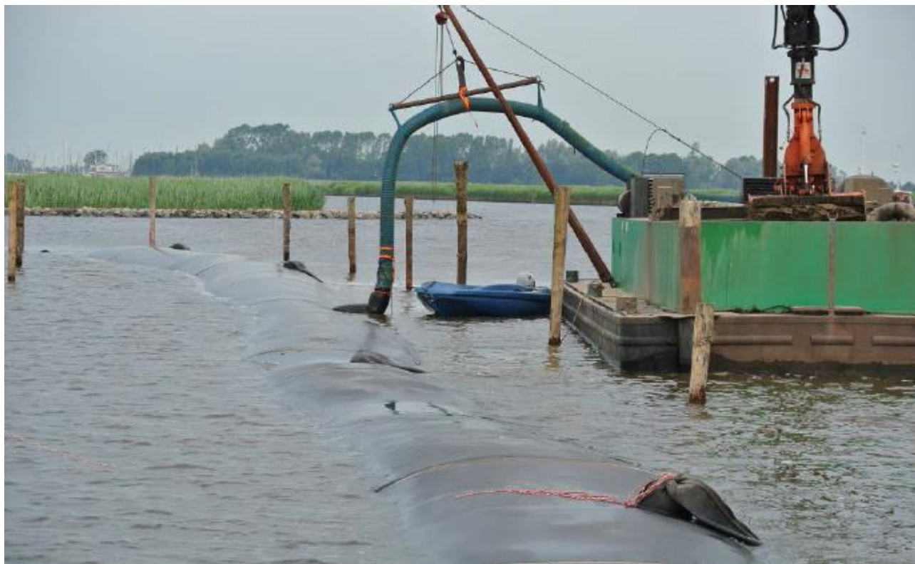
Figura 11. Instalación y relleno de geotubos. Fuente: Huesker.
