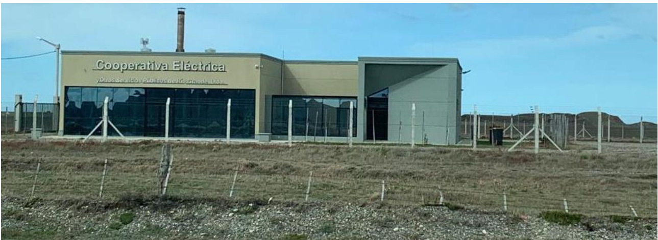
Figura 127. Crematorio de la Cooperativa Eléctrica de Río Grande. Noviembre 2022.
