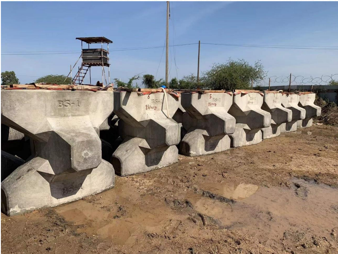
Figura 33. Fabricación y acopio de acrópodos.
