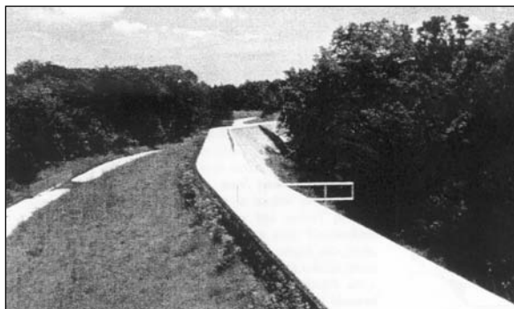
Obr. 5. Úprava vzdušného svahu hráze z válcovaného betonu přisypem a osetím (Woody Branch – USA)
