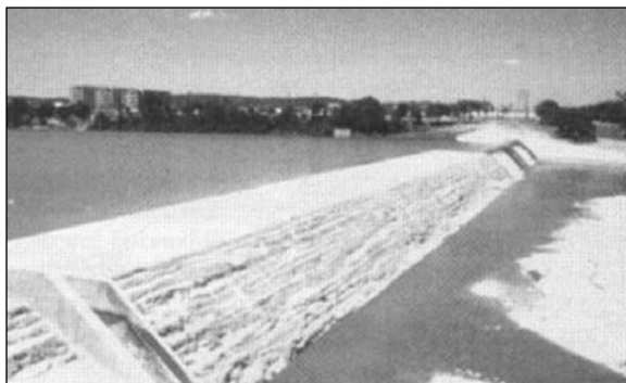
Obr. 2. Příklad neupraveného vzdušného líce hráze z válcovaného betonu (Kerrville – USA)
