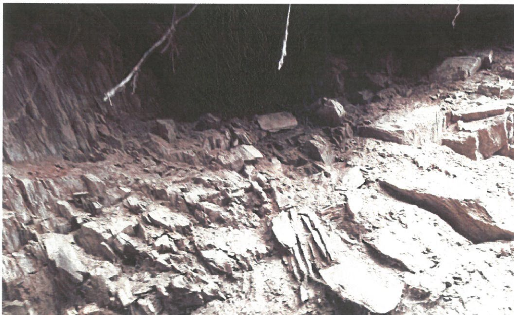
Foto – stávající stav horniny – břidlice.
