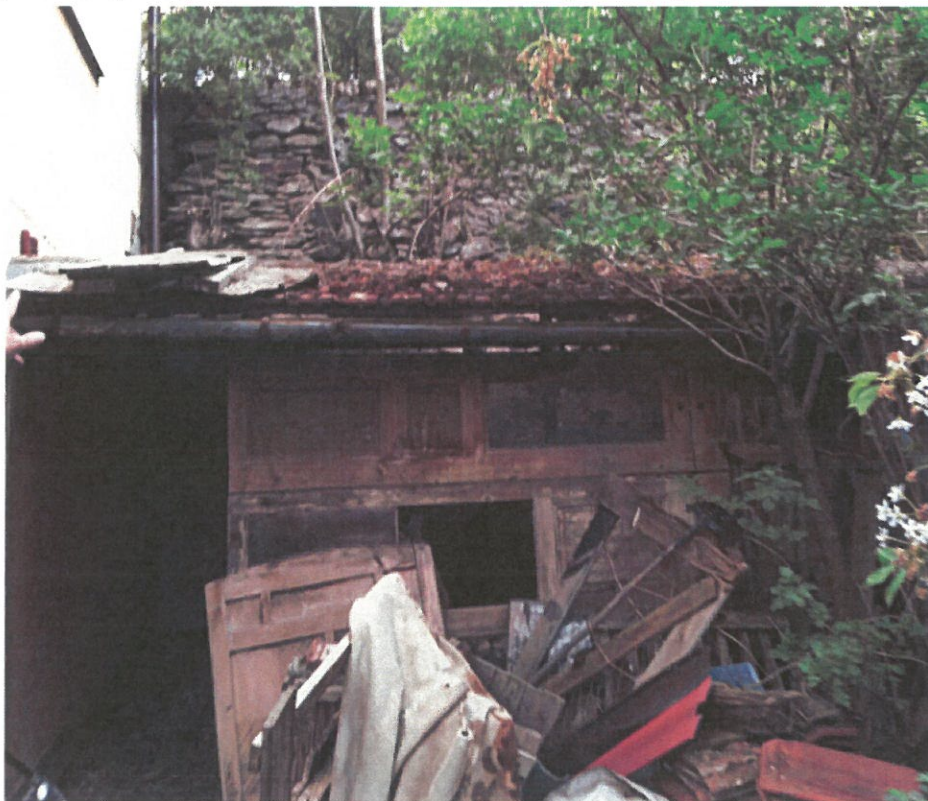
Foto – pohled z paty svahu na řešenou část původní opěrné zdi a přístřešku.
