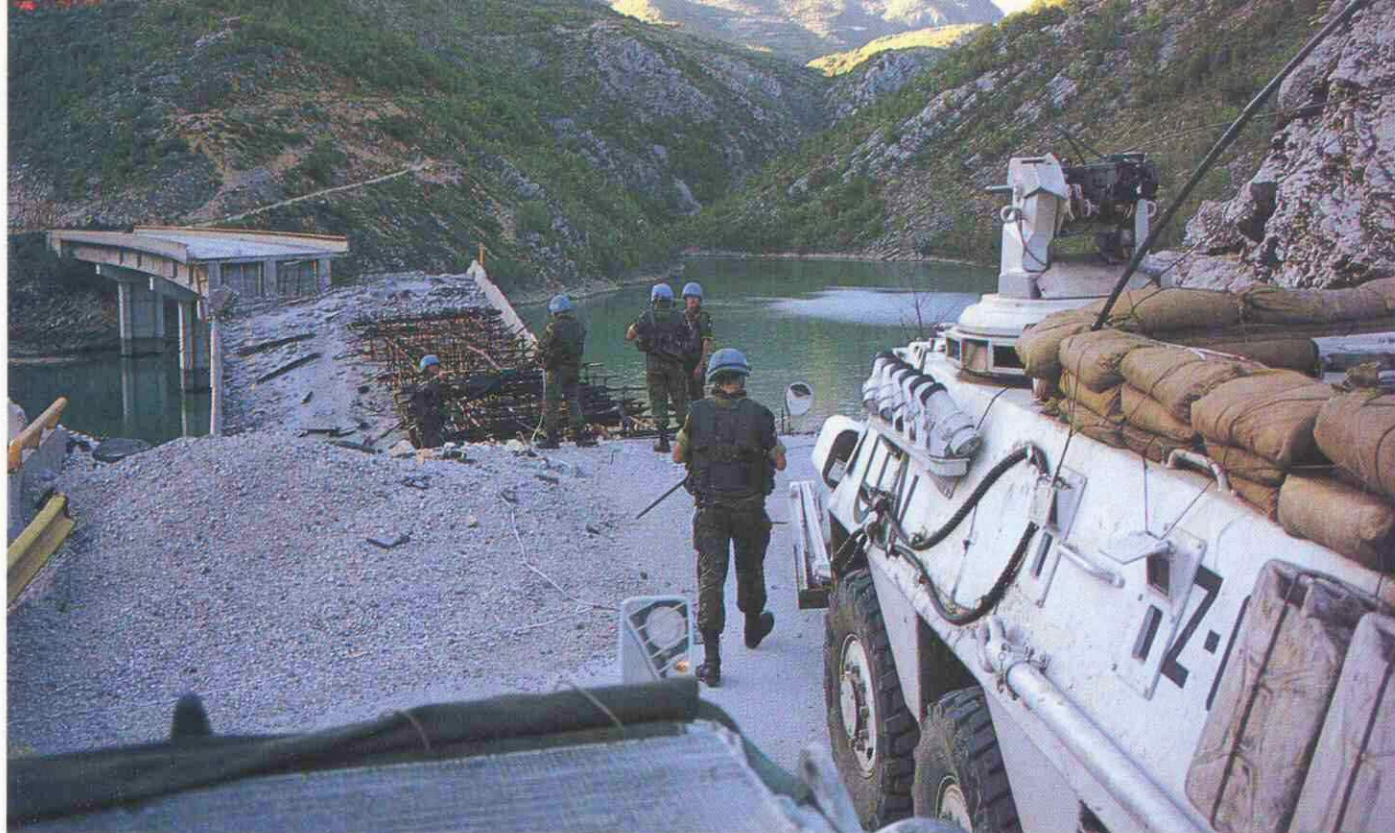
Ruta. Ingenieros de la BRIPAC, equipados con vehículos de combate de zapadores, colaboran en la reparación del puente de Bijela.
