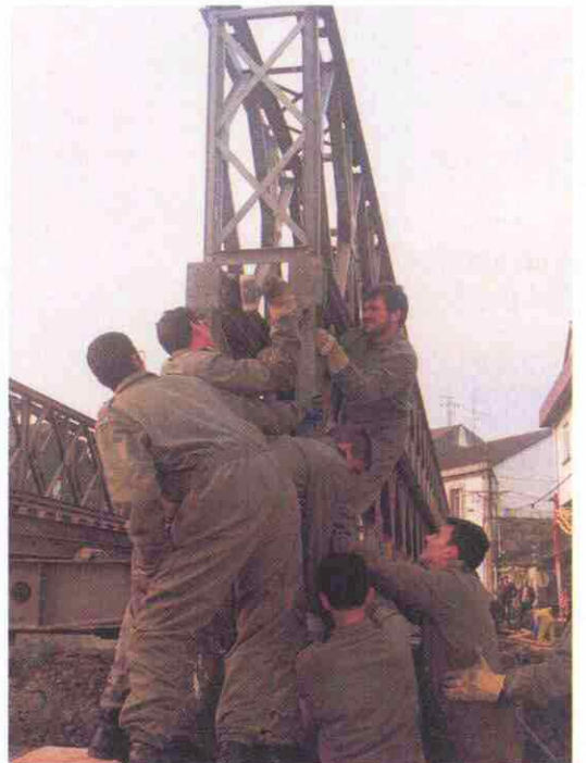
Instalación. Los pontoneros del Regimiento de Ingenieros de Salamanca colocaron un puente de tipo Bailey sobre el río Valdexería.
