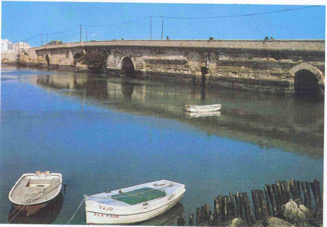
El puente de Suazo, sobre el caño de Sancti Petri, que salvaba el único paso terrestre de la isla gaditana con el resto del país y que se convirtió en el símbolo de la defensa frente al invasor.
