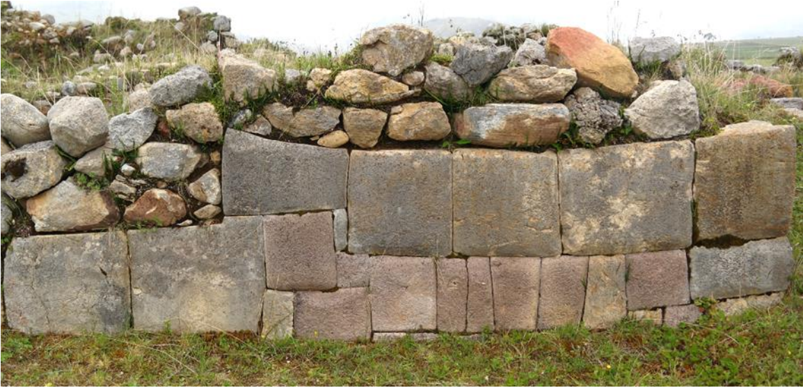
Figura 8: Aparejo sedimentario con hiladas alternas, nótese además la diferencia en el tamaño de los elementos líticos
