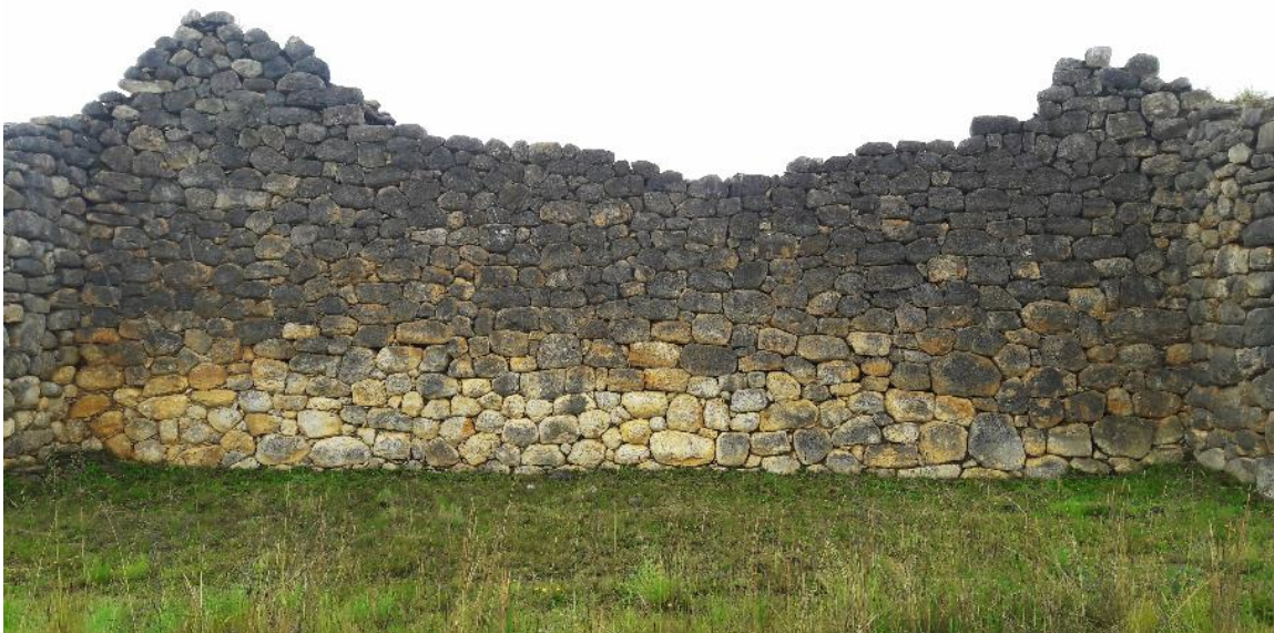
Figura 12: Aparejo tendiente al celular presente en uno de los muros-hastial de la Kallanka .
