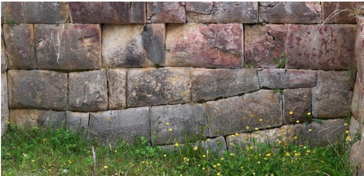
Figura 7: Aparejo sedimentario de uno de los recintos del Inkawasi o casa del inca, cuyas primeras hiladas muestran una inclinación evidente
