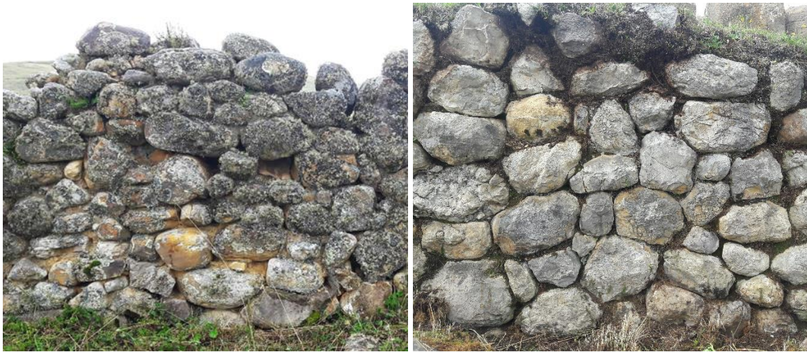
Figuras 3 y 4: Aparejo rústico elaborado con cantos rodados (izquierda) y con piedras canteadas sin el uso de pachillas (derecha)
