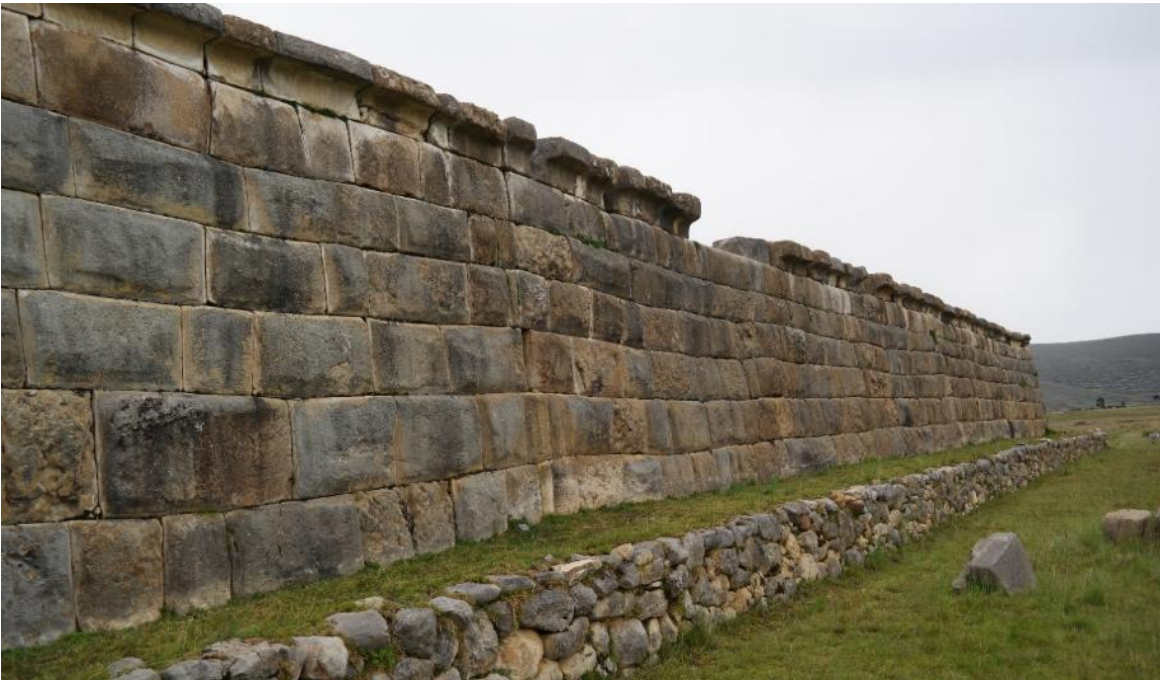
Figura 9: Aparejo sedimentario presente en uno de los paramentos del Ushnu, nótese el asentado rectilíneo y ligeramente ondulado en la parte central
