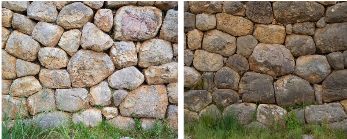
Figuras 10 y 11: Aparejo tendiente al celular, nótese las piedras de mayor tamaño en la parte central, desde las cuales se irradia el resto de piedras.
