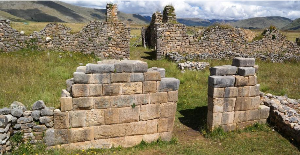
Figura 2: Vista panorámica del “Palacio Inca”, donde se aprecia el tipo de aparejo sedimentario en una de las Portadas y el aparejo rústico en las Kallankas
