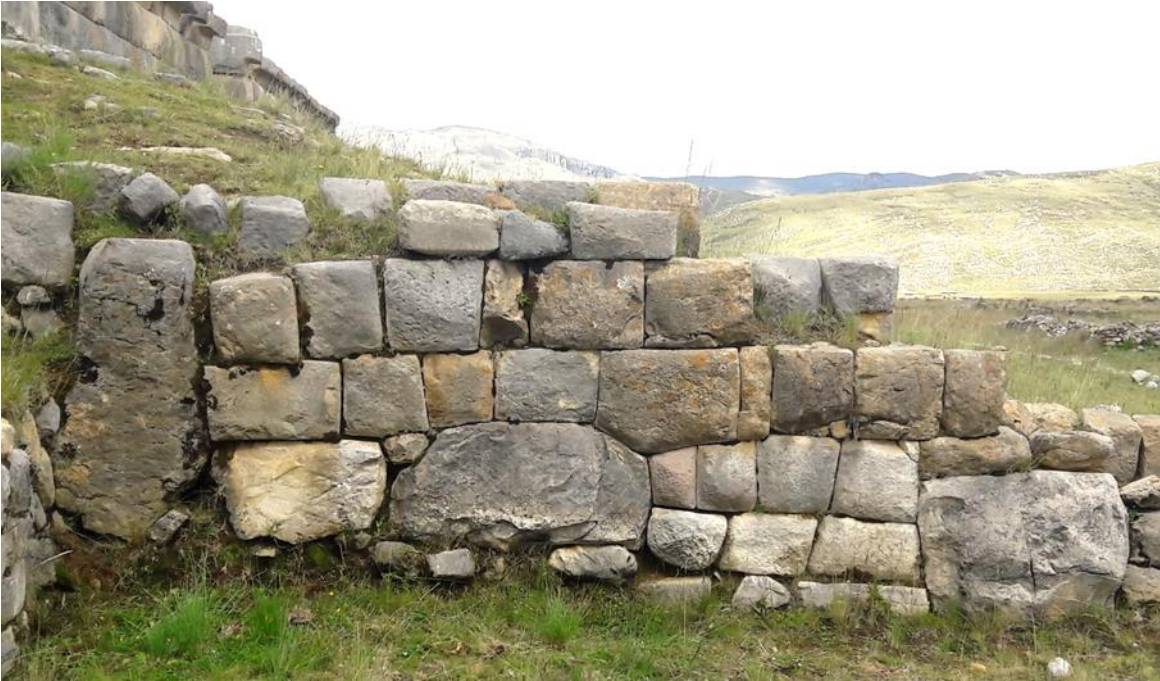
Figura 15: Muro baranda del Ushnu. Nótese la alternancia de las piedras sin labrar que actuarían a modo de columnas, con las piedras labradas a modo de relleno
