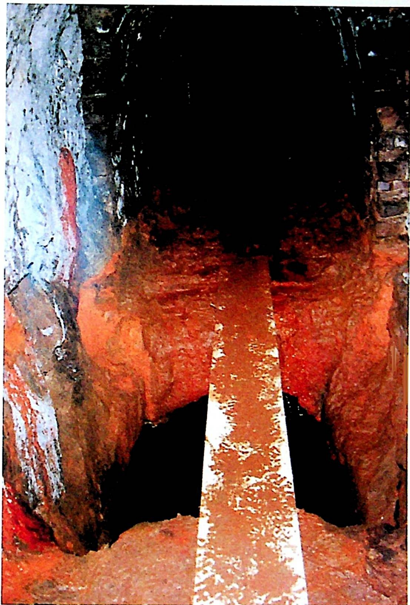
Geöffnetes Röschengewölbe
