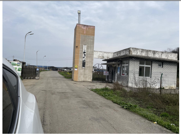
项目厂区大门
