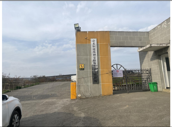
项目厂区大门
