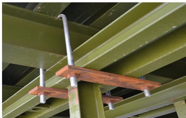
图 7 贝雷梁与分配梁连接示意图
