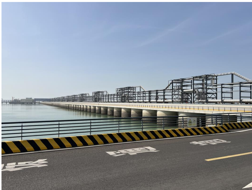
图 34 消防通道一期工程现状
