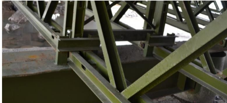
图 6 贝雷梁与承重梁连接示意图
