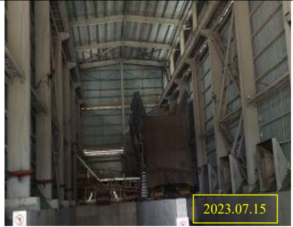
项目依托原有污泥接收坑
