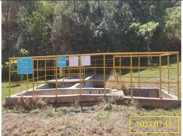
厂区雨水收集池
