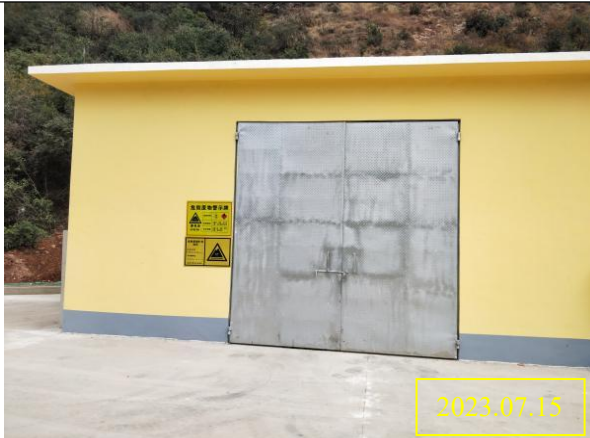
依托厂区现有危废暂存间
