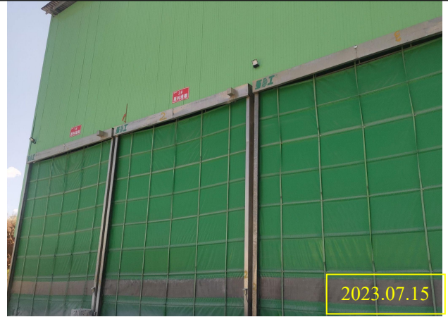
厂区原改性磷石膏原料库
