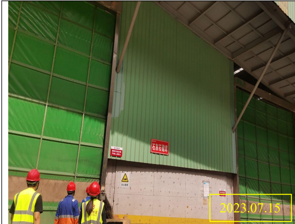
依托厂区联合储库（石灰石储库）
