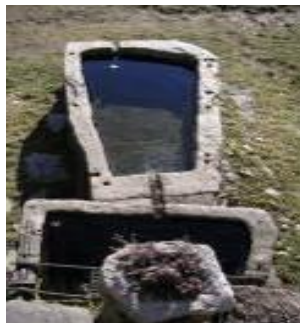
Fontana doppia addossata ad un edificio per la raccolta delle acque meteoriche (foto di Michele Martinucci e Stefano Pedrolì)
