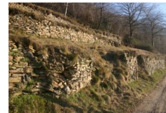
Sistema di terrazze coltivate a prato e sostenute da muri a secco (foto PB)
