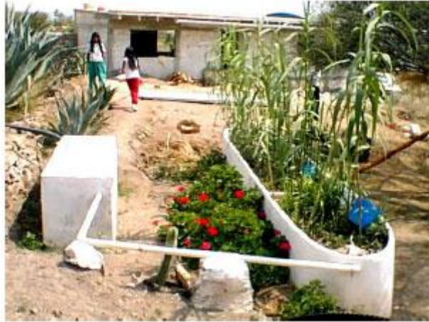
Figura 39. Lecho de hidrófitas para una vivienda rural.
