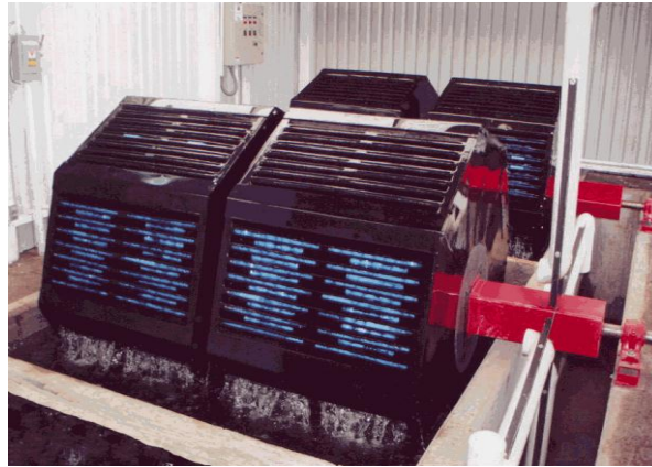
Figura 47. Biocontactor rotatorio (ACS Medio Ambiente).
