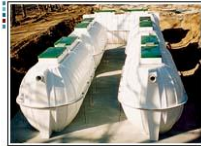
Figura 46. Reactor secuencial batch en planta paquete (Bistec).
