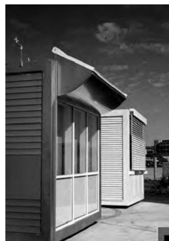
Figura 56: SINAI Concentrador Anidólico para Techo. Izquierda: Elementos del sistema. Fuente: [97] Derecha: Imagen de la instalación en una vivienda unifamiliar. Fuente: [A81]
