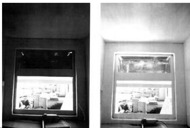
Figura 38: SINAI Estantería de Sombra Liviana. Izquierda: Luz del día en una habitación convencional con sombrilla. Derecha: habitación con el sistema instalado, se observa la variación del nivel lumínico; el resplandor es más fuerte cerca a la ventana, y va disminuyendo a mayor profundidad. Fuente: [23]
