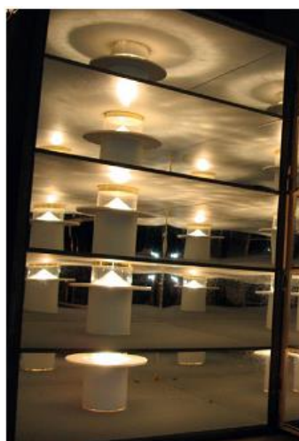
Figura 63: SINAI de Tubos de Luz con concentrador de LCP. Izquierda: corte en perfil del cono de aluminio que sirve como emisor de luz. Derecha: Vista interior que el ambiente iluminado con este sistema. Fuente: [111]
