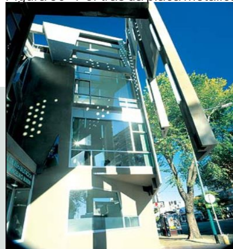
Figura 50 - Por trás da placa metálica
