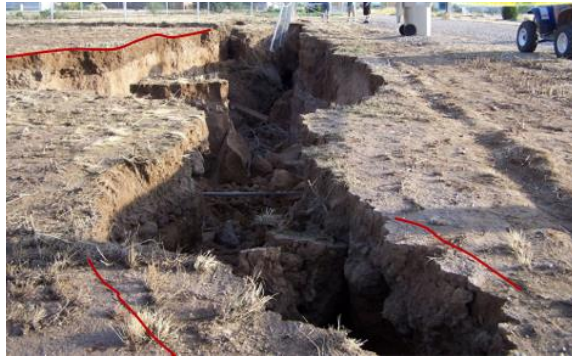
Figura 6. Erosión de una fisura. Adaptado de(Conway, 2016).
