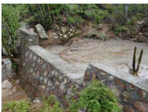
Figura 13. Obras hidráulicas transversales para cárcavas, fijación de sedimentos y protección de desaguaderos naturales (Fuente: de Instituto Nacional de Vías-Colombia-1998 & Cardoza, 2013).
