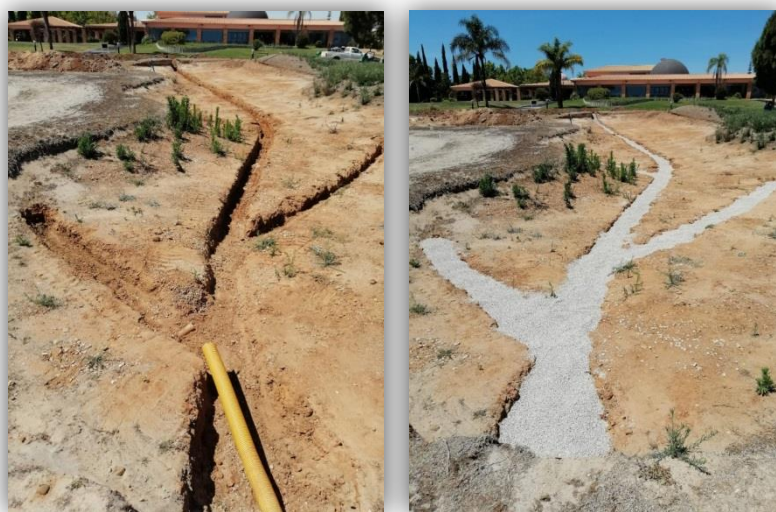
Figura 8. Processo de construção do sistema de drenagem.
