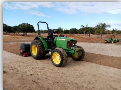
Figura 7. Aerificação para partir a camada superficial do terreno.
