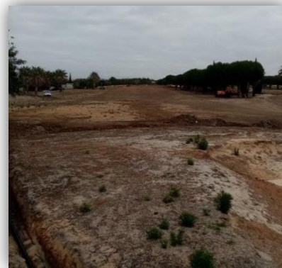
Figura 6. Terreno após eliminação de relvas com infestantes visíveis.
