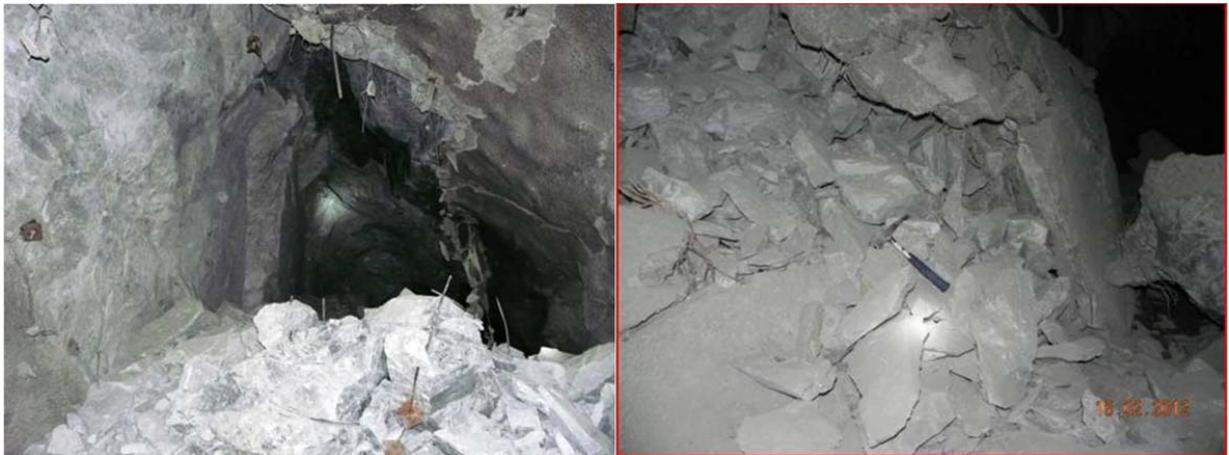
Figura 1.4 Respuesta generada por fallas ante el avance de las labores en la mina El Teniente. En la izquierda se observa un estallido de rocas, en la derecha el colapso de un túnel. Imágenes tomadas de (Seguel, 2012)
