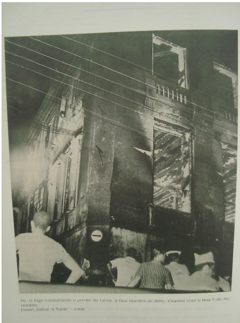
(19) O fogo consumindo o prédio do Liceu, à Rua Guedes de Brito, esquina com a Rua 7 de Novembro. Fonte: Jornal "A Tarde", 1968.
