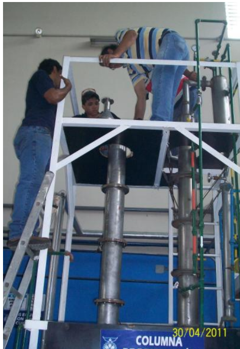
Fig. 80.- Colocación de la cabeza de la columna.
