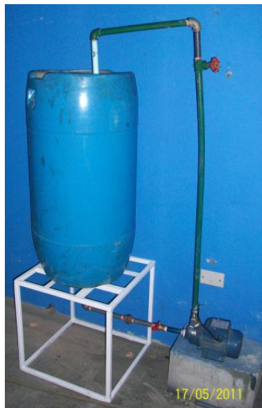
Fig.82.- Instalación del tanque de alimentación y la bomba.
