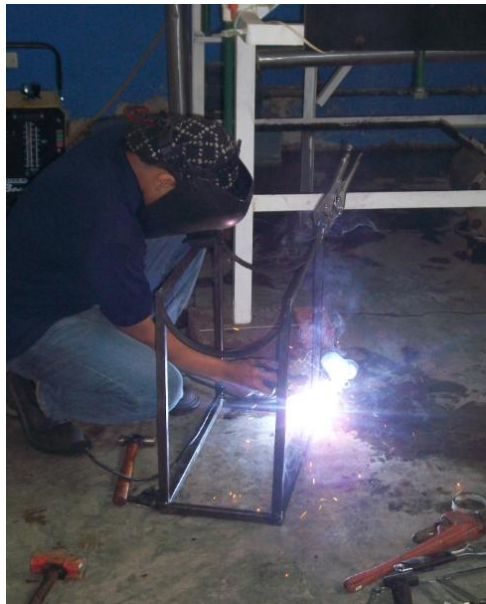
Fig.70.- Construcción del soporte del reboiler.
