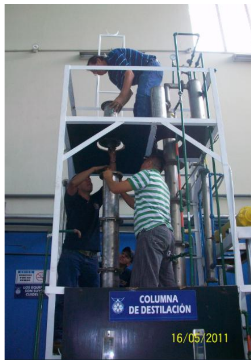
Fig. 53.- Instalación de los cuerpos de la columna de destilación.
