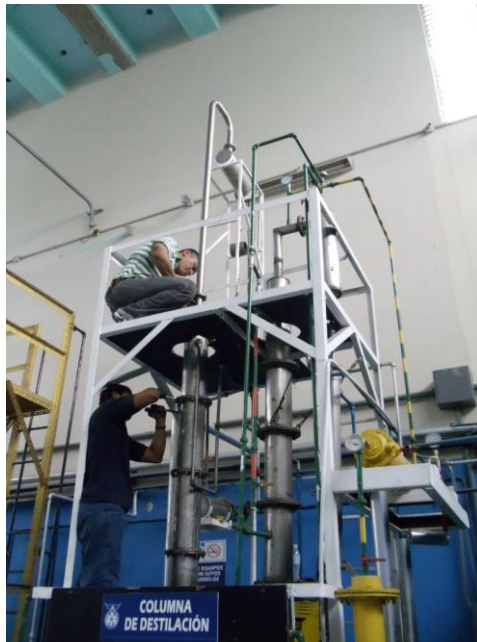
Fig.81.- Ajuste de los pernos de la columna y unión al condensador total.
