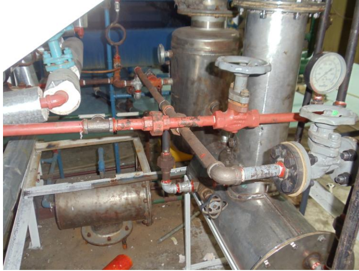
Fig. 83.- Instalación de las líneas de steam al reboiler, y calentador del alimento.
