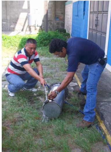
Fig.73.- Limpieza de los equipos previa a la instalación.
