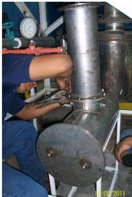
Fig.76.- Colocación del reboiler y el primer cuerpo de la columna de destilación.
