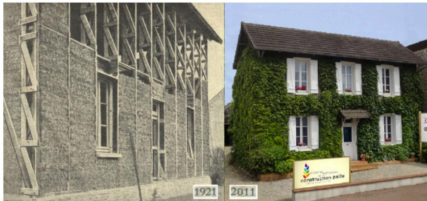
Figura 1.3 Exemplo de uma habitação construída com fardos de palha em França
