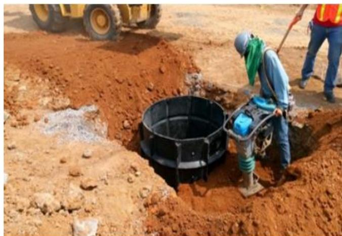
**Ilustración 17. Pozo de inspección polietileno de alta densidad.**
