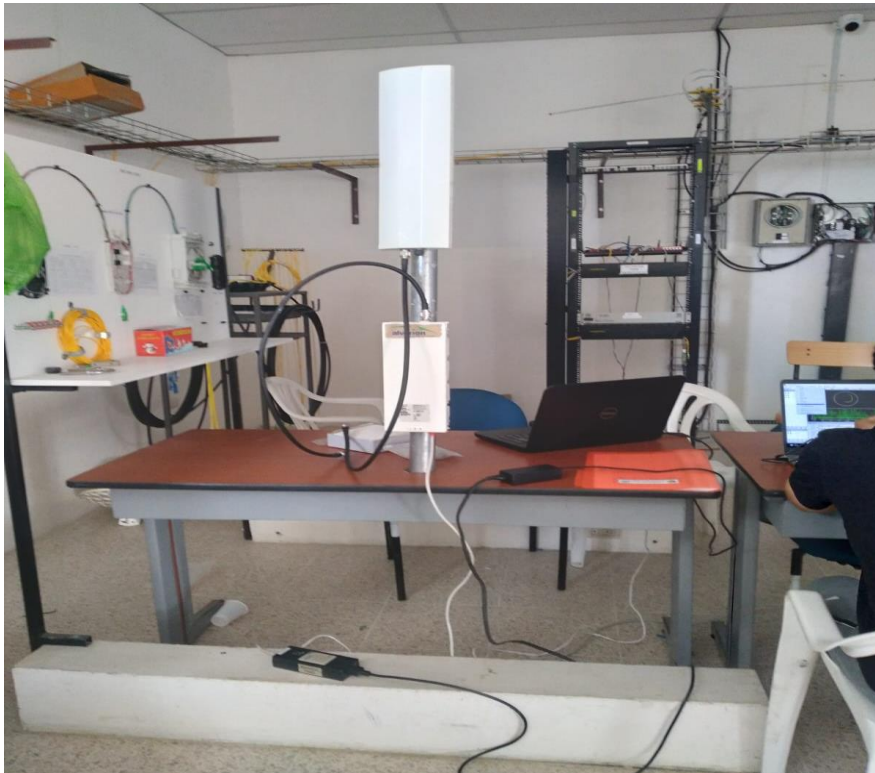
ANEXO 3. Ubicación de los equipos Alvarion en el laboratorio de telecomunicaciones en la UPSE, para la creación del enlace PtMP.
