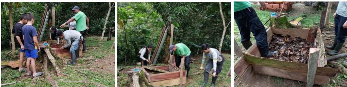
Figura 7. Construcción de paca biodigestora en la Reserva Agroecológica Los Monos.
