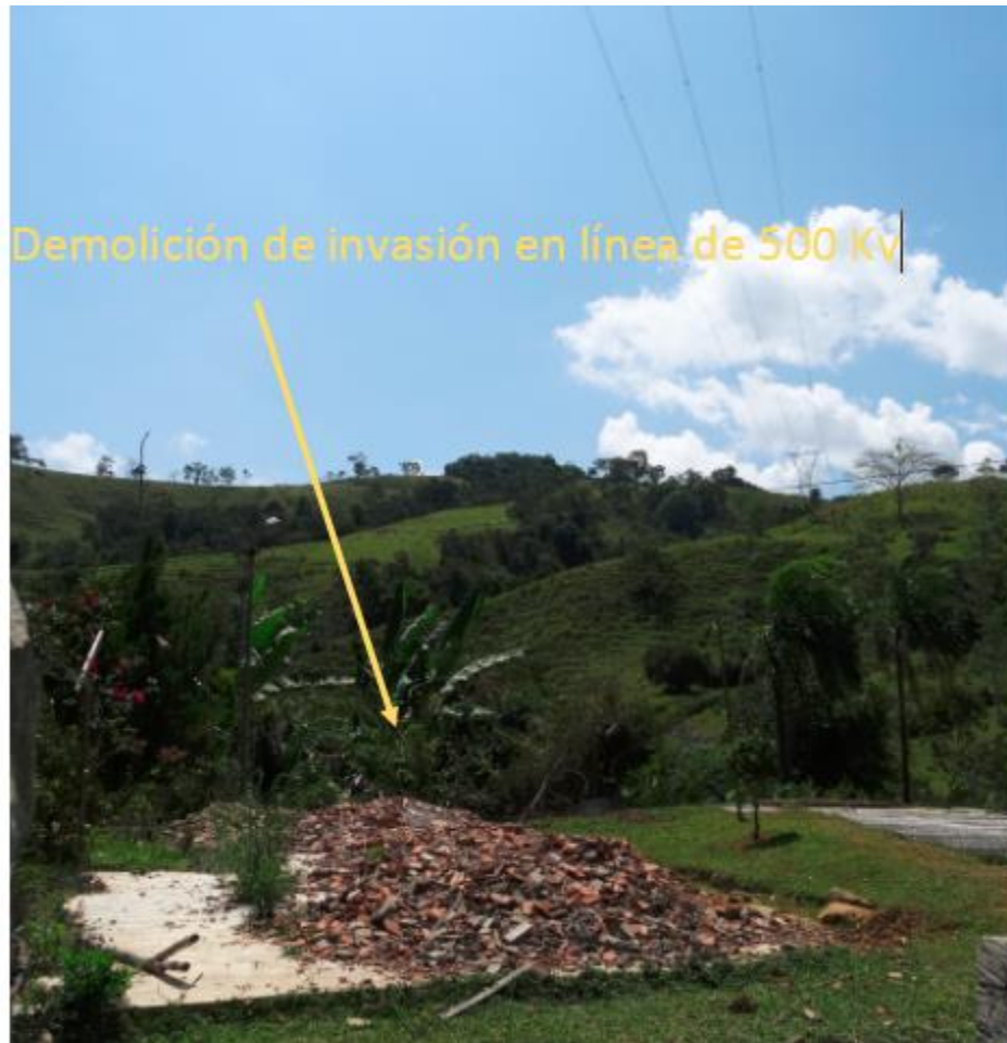
Imagen 16. Demolición de invasión en línea de 500 kV. 16
