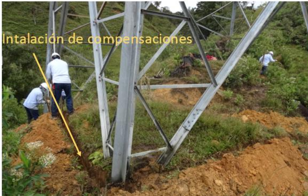
Imagen 17. Instalación de puesta a tierra línea de 230 kV. 17
