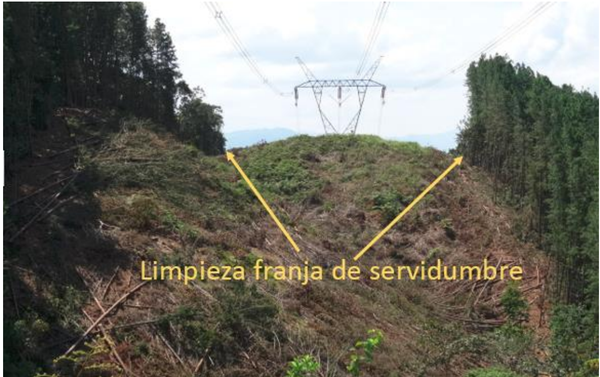
Imagen 15. Limpieza de franja de servidumbre línea de 500 kV 15
