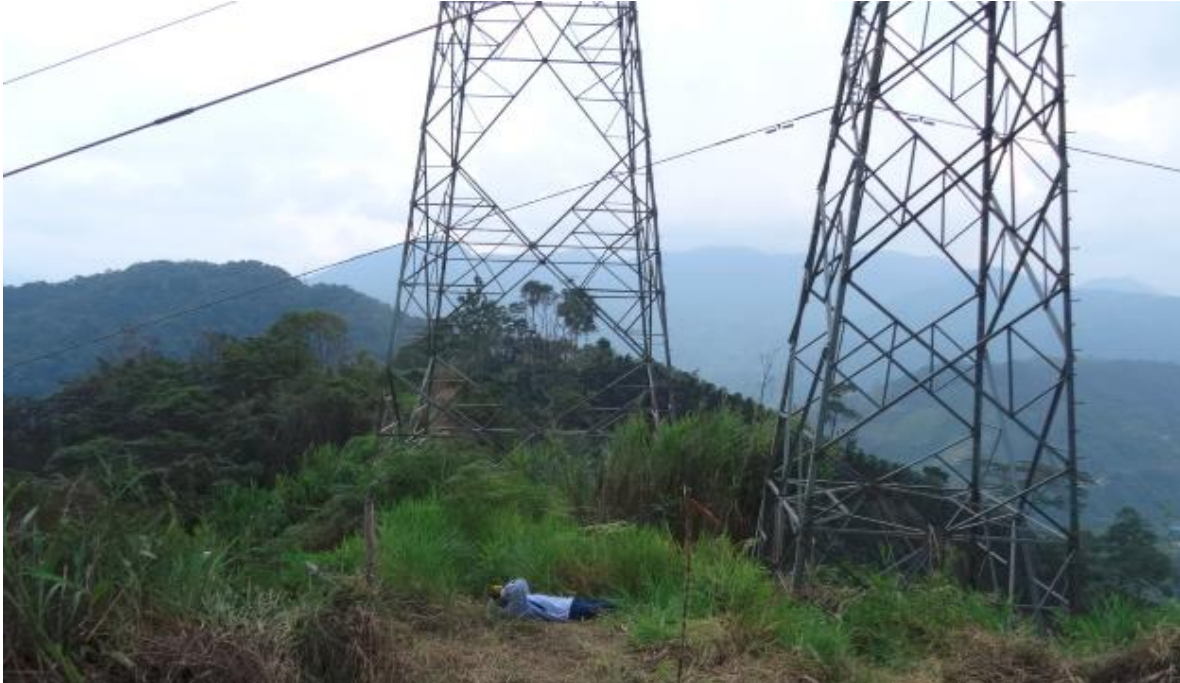
Imagen 14. Identificación de posible acercamiento en línea de 220 kV. 14
