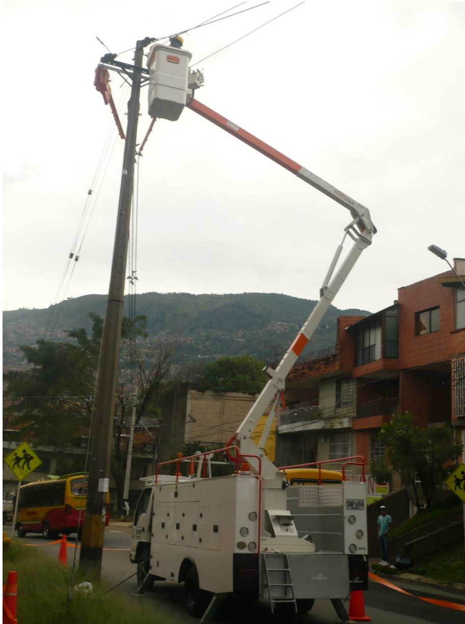
Imagen 18. Carro canasta para trabajos bajo tensión 18
