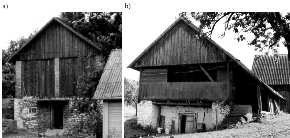
Ryc. 78. Jednobudynkowe liniowe obiekty inwentarsko-gospodarcze pod jednym dachem o funkcji składowej i inwentarskiej na różnych poziomach i z częściowo zagłębionymi pomieszczeniami inwentarskimi wzniesione w dzisiejszym woj. małopolskim w dwudziestoleciu międzywojennym: a) Przeginia, obiekt z I poł. XX wieku, stan w 1996; b) Skrudzina, obiekt z 1928, stan w 2000 r. (fot. autorka)
