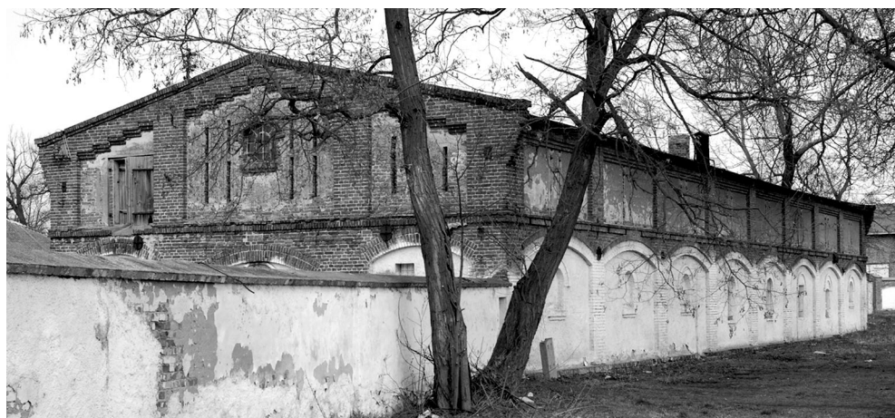
Ryc. 15. Folwarczna ceglana obora z 1887 r. Przyziemie otynkowane w czasie użytkowania budynku przez PGR. Jarogniewice (woj. wielkopolskie), stan w 2006 r. (fot. autorka)
