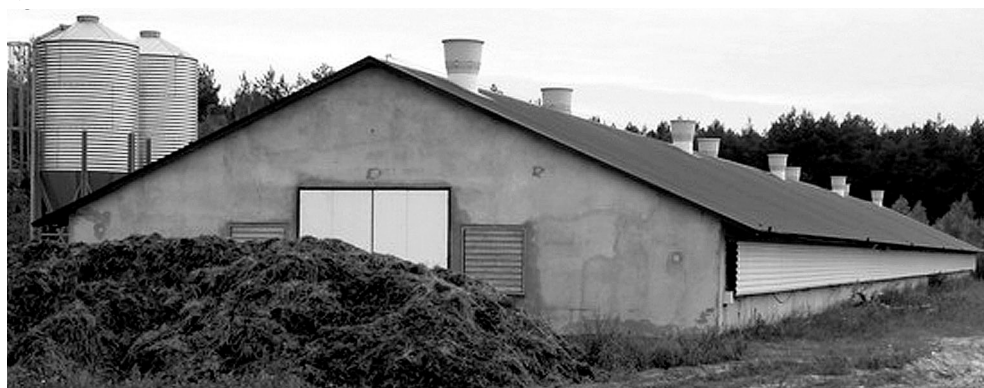
Ryc. 107. Kurniki przemysłowe – tuczarnie brojlerów, wzniesione w 2006 roku: a) kurnik o długości 150 m w Bieńkowicach k. Raciborza, b) kurnik o długości 100 m w Otłoczynie k. Torunia. Konstrukcja szkieletowa, żelbetowa. Ściany z bloczków z betonu komórkowego ocieplone styropianem. Konstrukcja dachu – stalowe więzary kratowe. Dach pokryty stalową blachą trapezową. Posadzka betonowa (źródło: mat. reklamowe firmy ZAW-BUD; http://www.zawbud.pl/ )
