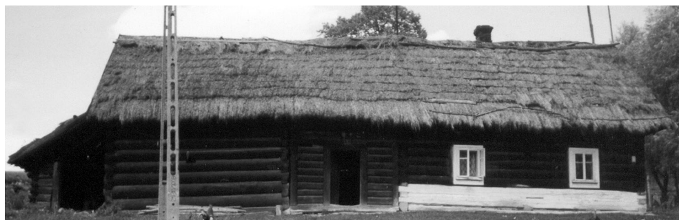
Ryc. 39. Mieszkalno-gospodarcza szerokofrontowa chałupa wznoszona od 1901 r. w Rożnowicach (woj. małopolskie). Zrębowa część inwentarska oddzielona sienią od zrębowo-słupowej części mieszkalnej, stan w 2000 r. (fot. autorka)
