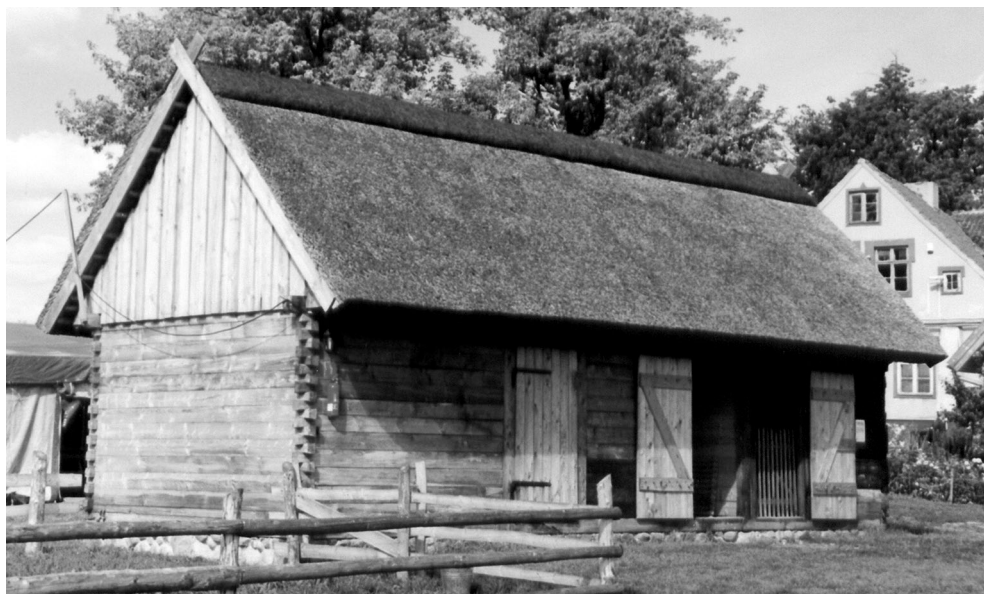
Ryc. 91. Wzniesiony w I poł. XX wieku w Krzyżewie wolno stojący zrębowy budynek inwentarski z poddaszem składowym i dachem dwuspadowym krytym trzcina na gładko, użytkowany w II poł. XX w., obecnie w Muzeum Kultury Ludowej w Węgorzewie (fot. autorka)
