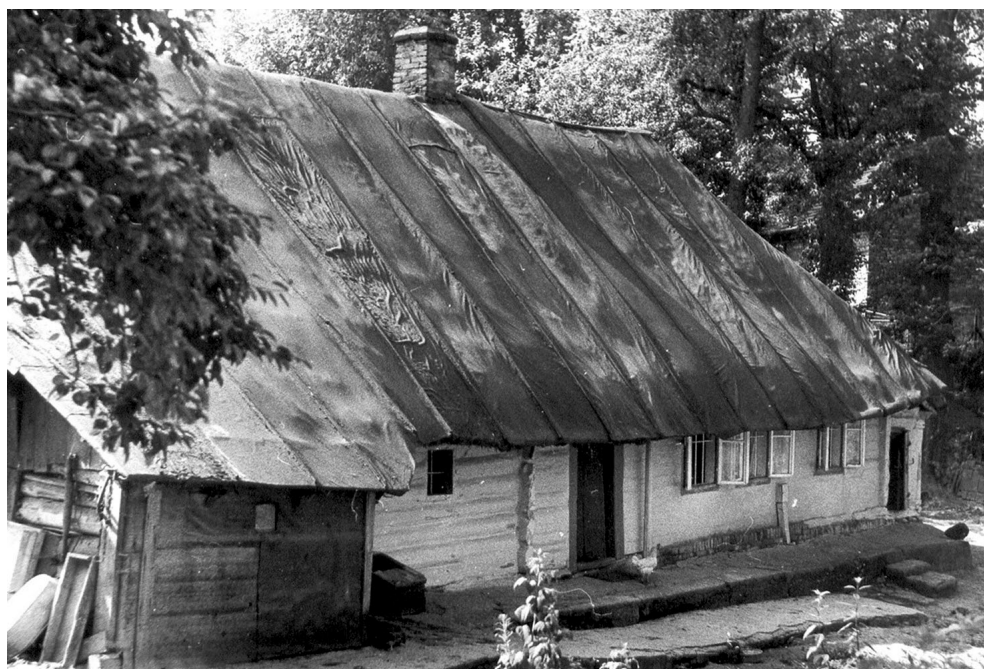
Ryc. 50. Drewniany budynek mieszkalno-gospodarczy wznoszony i rozbudowywany od 1888 r. Pierwotnie kryty słomą, w II poł. XX w. nakrytą papą. Bieńczyce, obecnie w granicach Krakowa, stan w 1988 r. (fot. autorka)
