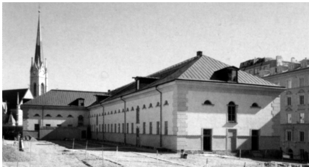
Ryc. 34. Stajnie magistrackie z 1817 r. w Sztokholmie zaadaptowane na bibliotekę, proj. White Arkitekter AB, 2002–2006 r. (źródło: Arkitektur 1/2006, fot. M. Plunger)
