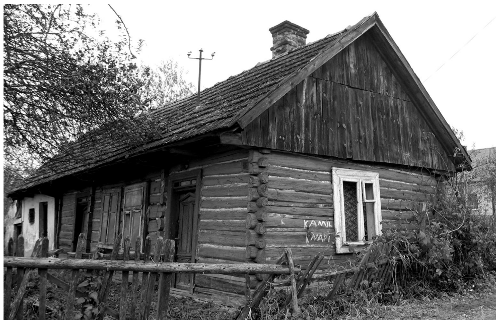
Ryc. 69. Jednobudynkowy obiekt mieszkalno-gospodarczy pod jednym dachem w Bielczy (woj. małopolskie), rozbudowywany od XIX w., pierwotnie kryty słomą, typ B I.J.4a (tab. 1), stan w 2010 r. (fot. autorka)
