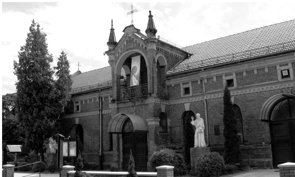
Ryc. 108. Stajnia koni wyjazdowych z wozownią wzniesiona na przełomie XIX i XX wieku. Od roku 1911 kaplica, a od 2002 r. kościół rzymskokatolicki. Prokocim, obecnie w granicach Krakowa, stan w 2011 roku (fot. autorka)
