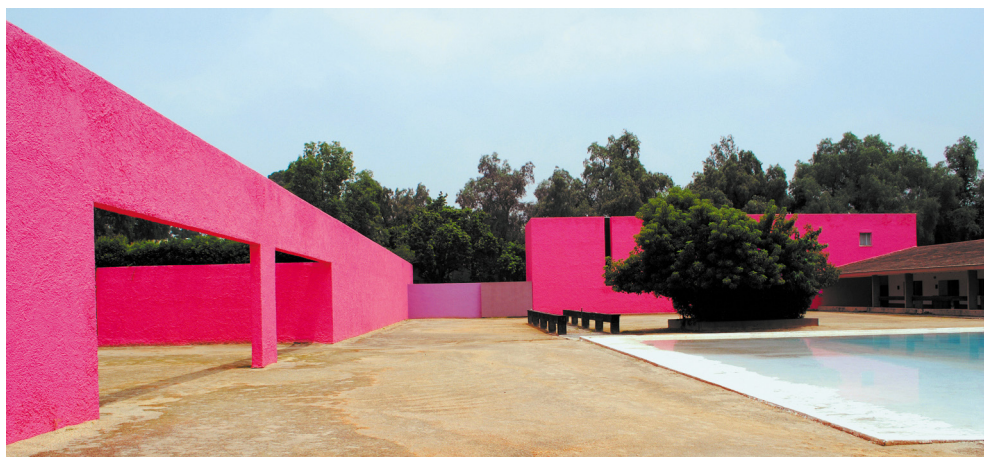
Ryc. 111. Wzniesione w latach 1966–1968 stajnie w posiadłości San Cristobal, Las Clubes k. Mexico City, proj. L. Barragán, stan w 2010 roku (źródło: http://www.mexconnect.com )
