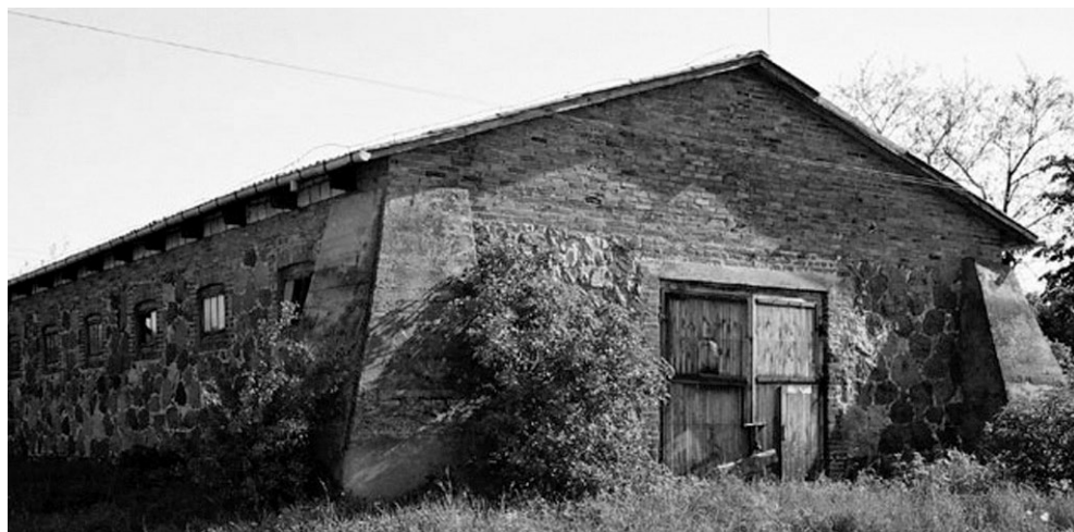
Ryc. 26. Ceglano-kamienna obora z II poł. XIX w. w Łysowie na południowym Podlasiu (woj. mazowieckie), stan w 2009 r. (fot. autorka)
