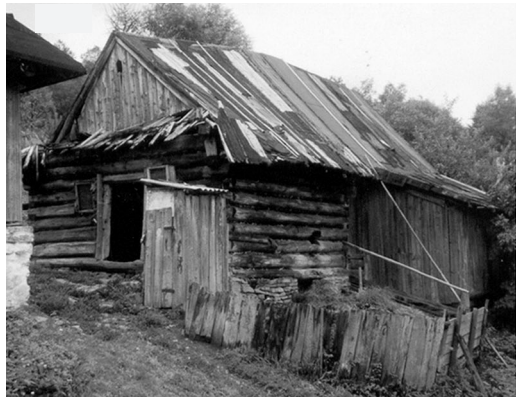
Ryc. 66. Wolnostojące budynki inwentarskie z poddaszem składowym z XIX/XX w. z obszaru woj. śląskiego, typ A1 (tab. 1), stan w 2000: a) budynek zrębowy, Przyłęków, b) budynek wzniesiony z kamienia wapiennego, Święta Anna (fot. autorka)
