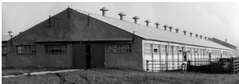
Ryc. 98. Obora z prefabrykowanych elementów żelbetowych wzniesiona w 1976 r. w PGR w Gołuszowicach (woj. opolskie), 1980 r. (fot. autorka)
