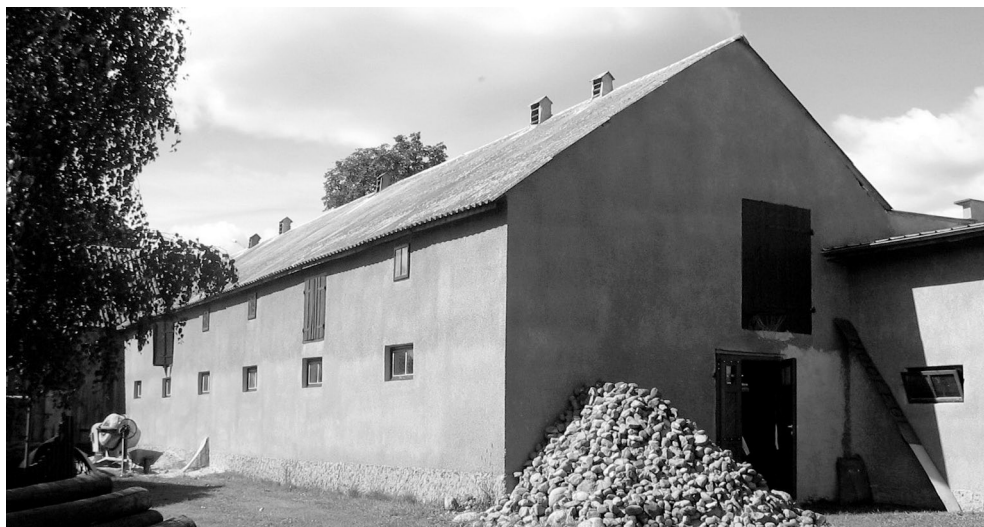
Ryc. 92. Budynek inwentarski o konstrukcji szkieletowej z drewnianą ścianką kolankową podwyższonego poddasza w Suraziu (woj. podlaskie) w całości otynkowany w celu wątpliwego polepszenia parametrów technicznych, środowiskowych i sanitarnych, stan w 2007 roku (fot. autorka)
