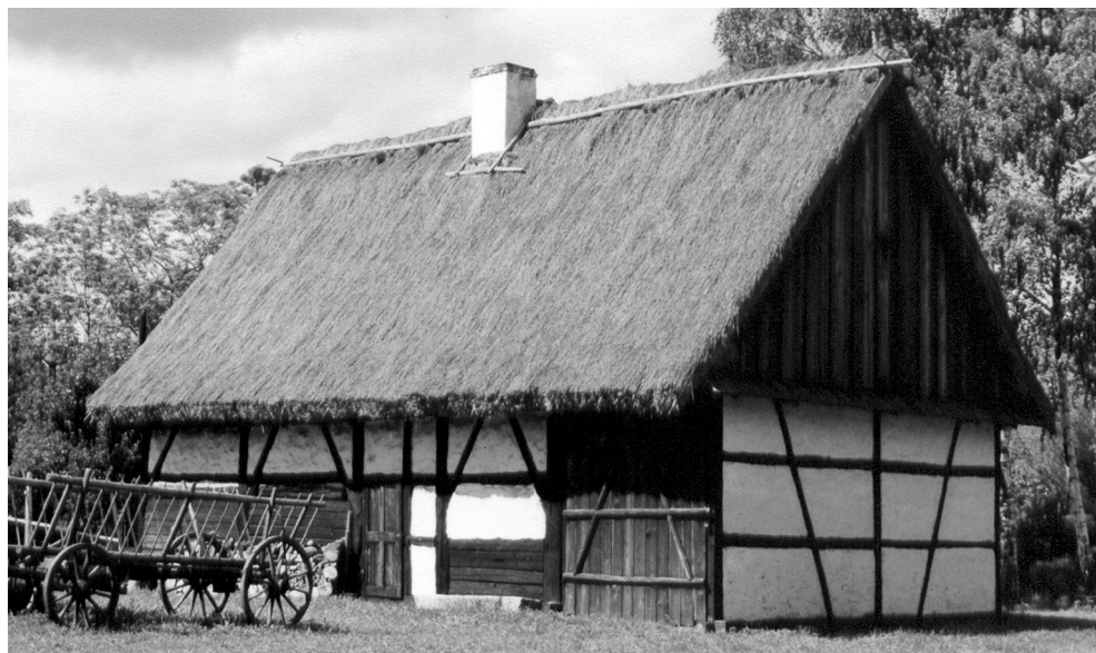
Ryc. 87. Szerokofrontowa chałupa z poddaszem składowym wznoszona od końca XVIII w. w Starym Lesie na Nizinie Śląskiej z funkcją mieszkalną i inwentarską pod jednym dachem. Użytkowany w II poł. XX w., obecnie w Muzeum Wsi Opolskiej w Opolu (fot. autorka)
