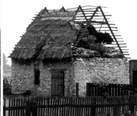
Ryc. 66. Wolnostojące budynki inwentarskie z poddaszem składowym z XIX/XX w. z obszaru woj. śląskiego, typ A1 (tab. 1), stan w 2000: a) budynek zrębowy, Przyłęków, b) budynek wzniesiony z kamienia wapiennego, Święta Anna (fot. autorka)
