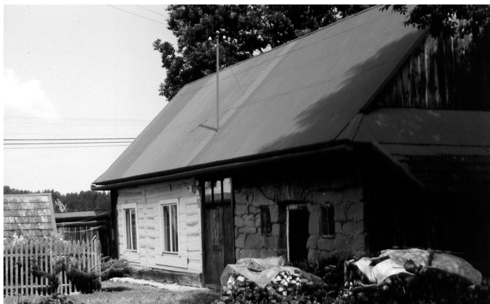
Ryc. 40. Mieszkalno-gospodarcza chałupa wznoszona od II poł. XVIII w. w Naprawie (woj. małopolskie). Część mieszkalna zrębowa, część inwentarska z miejscowego piaskowca, ceglane nadproże nad wejściem do części inwentarskiej, stan w 1999 r. (fot. autorka)
