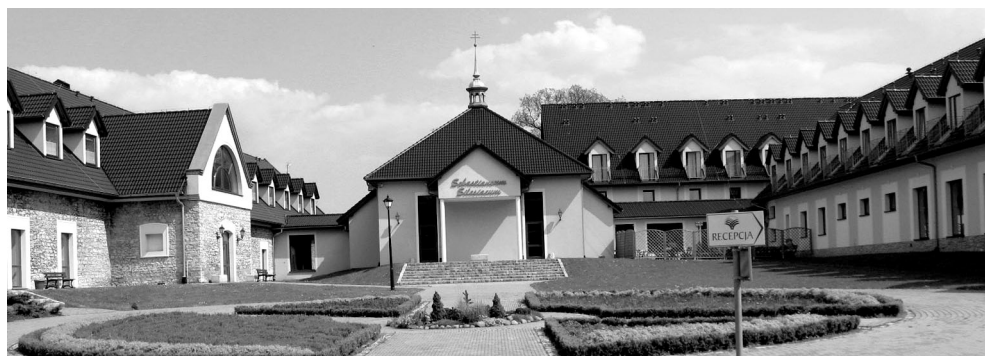
Ryc. 35. Sebastianum Silesiacum. Zespół Turystyczno-Wypoczynkowo-Rehabilitacyjny Caritas Diecezji Opolskiej w Kamieniu Śląskim. Zaadaptowane na potrzeby ośrodka pofolwarczne stajnie – lewe skrzydło widocznego na ilustracji założenia (źródło: http://sanatorium.kamienislaski.pl/ )
