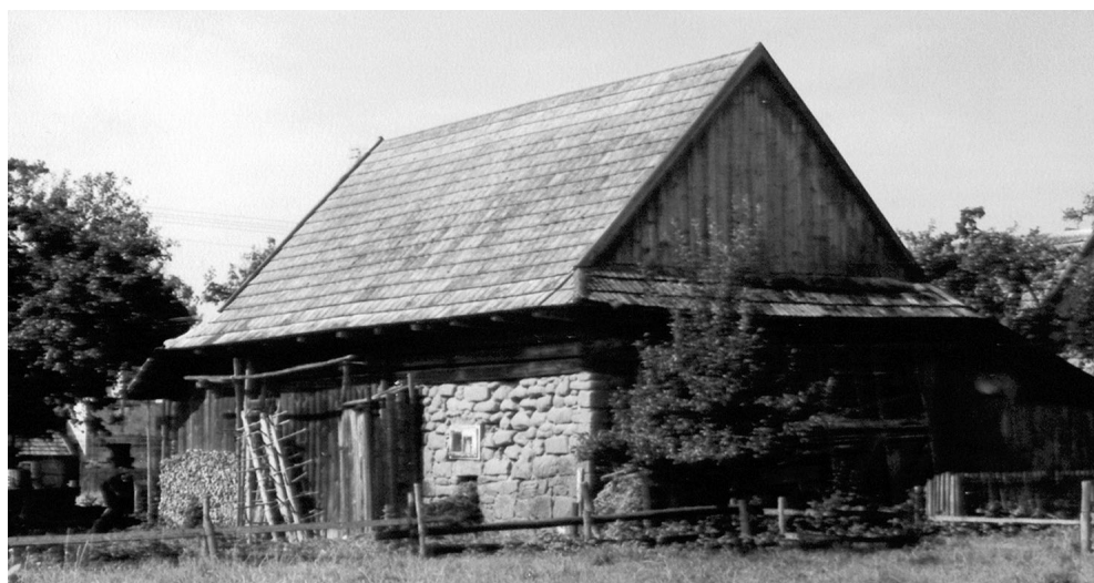
Ryc. 46. Wolnostojący budynek inwentarsko-gospodarczy z pocz. XX w. w Naprawie (woj. małopolskie). Część inwentarska z piaskowca, część składowa drewniana o konstrukcji szkieletowej, obita deskami, stan w 1999 r. (fot. autorka)
