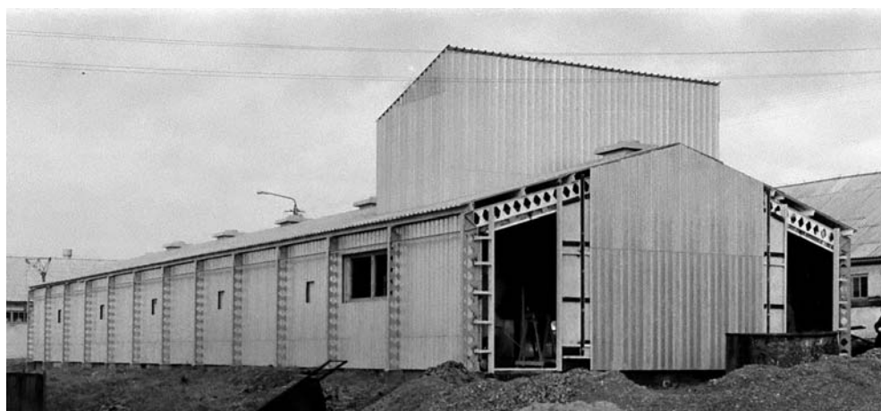
Ryc. 100. Wzniesiona w połowie lat 70. XX w. eksperymentalna tuczarnia trzody chlewnej, Kostkowie-Kępa (woj. śląskie). Projekt wykonany przez zespół Osadnictwa i Budownictwa Wiejskiego Politechniki Krakowskiej, gł. projektant Z. Kuchta (fot. Z. Kuchta)
