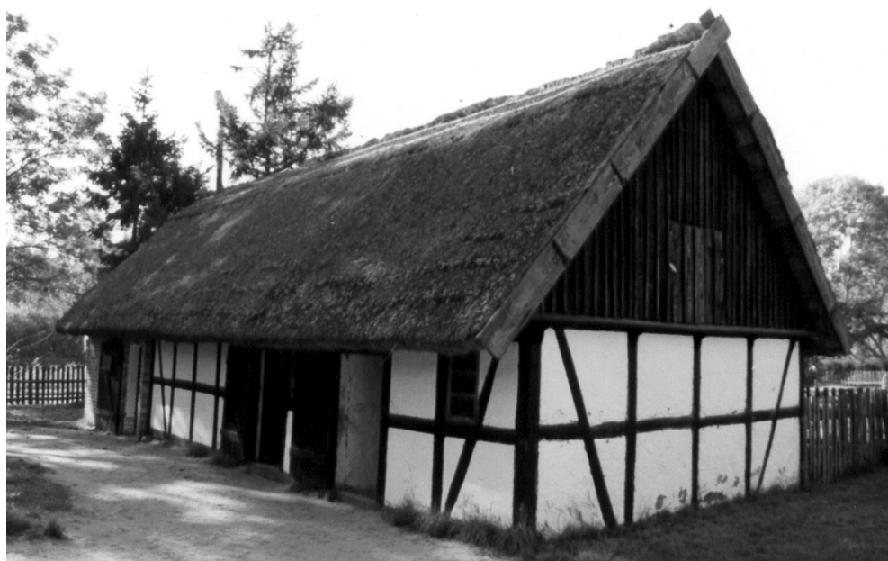
Ryc. 84. Wolnostojący budynek inwentarski z poddaszem składowym, dach dwuspadowy kryty trzcina na gładko. Obiekt o konstrukcji szkieletowej z szachulcowym wypełnieniem z końca XIX w. (ok. 1850), użytkowany w II poł. XX w. Zachowany in situ w Muzeum Wsi Słowińskiej w Klukach (fot. autorka)
