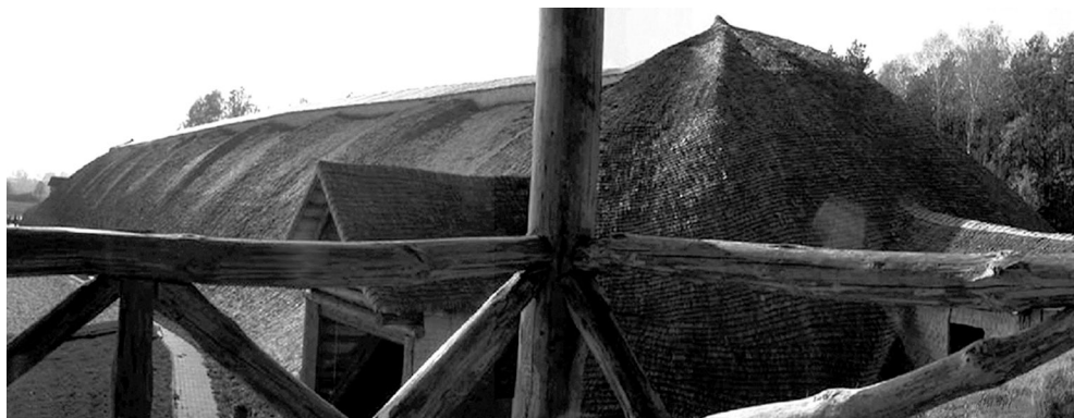
Ryc. 109. Stajnie w Chojnowie k. Warszawy, ujeżdżalnia. Konstrukcja ujeżdżalni została wykonana z 25-metrowych giętych pni sosnowych. Dach pokryto wiórem osikowym. Stan w 2006 r., proj. J. Kozicki (fot. autorka)
