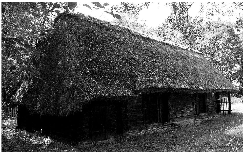
Ryc. 90. Wolnostojący zrębowy budynek inwentarsko-gospodarczy z dachem czterospadowym krytym słomą na gładko, wznoszony od XVIII wieku w Wichrowie na Nizinie Śląskiej. Piewotnie stanowił jednoprzestrzenny obiekt z pomieszczeniem dla bydła i koni, później dobudowano chlewy i wozownię. Użytkowany w II poł. XX wieku. Obecnie w Muzeum Wsi Opolskiej w Opolu (fot. autorka)
