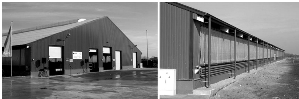
Ryc. 106. Obora kurtynowa typu Racibórz (źródło: http://www.rolnictwo.com.pl )
