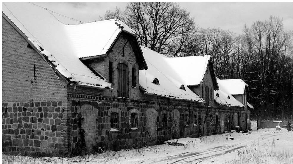
Ryc. 20. Kamienno-ceglany XIX-wieczny budynek inwentarski, Golice (woj. zachodniopomorskie), stan w 2006 r. (fot. autorka)
