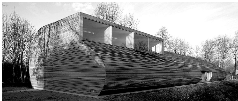
Ryc. 113. Owczarnia o drewnianych ścianach zewnętrznych mocowanych do wygiętych dźwigarów stalowych w Almere (Holandia), 2008 roku. W budynku funkcja dydaktyczno-edukacyjna. Proj. 70F Architecture, fot. L. Kramer (źródło: http://www.70f.com )
