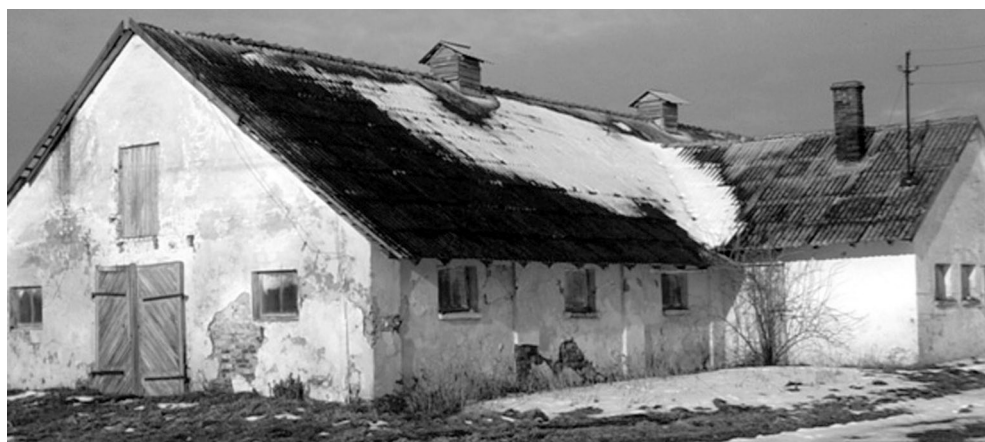
Ryc. 29. Folwarczny budynek inwentarski w Żurawcach (woj. lubelskie) użytkowany przez Spółdzielnię Produkcji Rolnej, stan w 2010 r. (fot. autorka)
