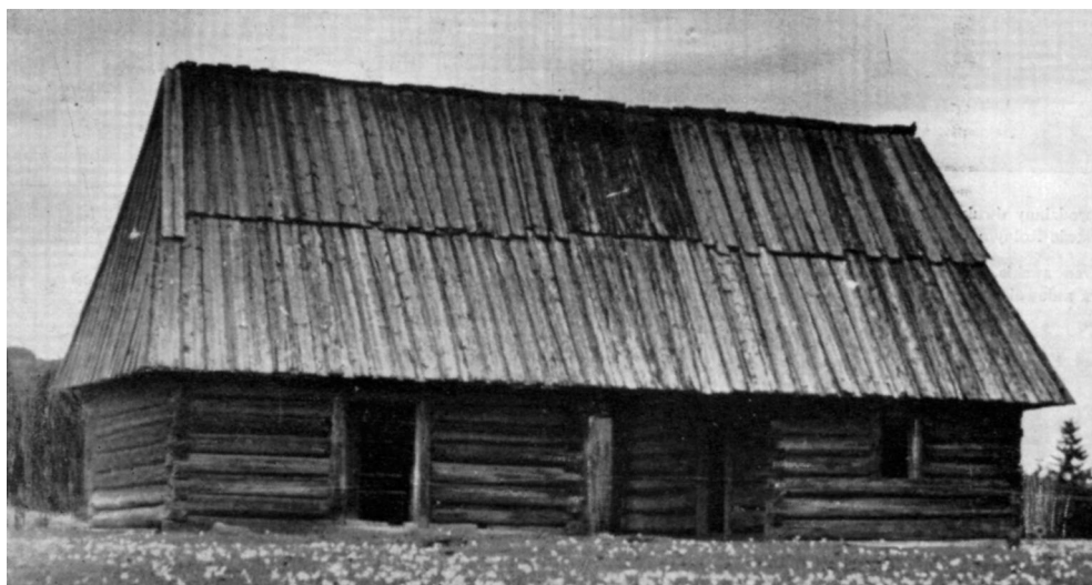
Ryc. 58. Szałas pasterski z izbą mieszkalną na polanie Biały Potok (źródło: I. Tłoczek, Dom mieszkalny na polskiej wsi , PWN, Warszawa 1985)
