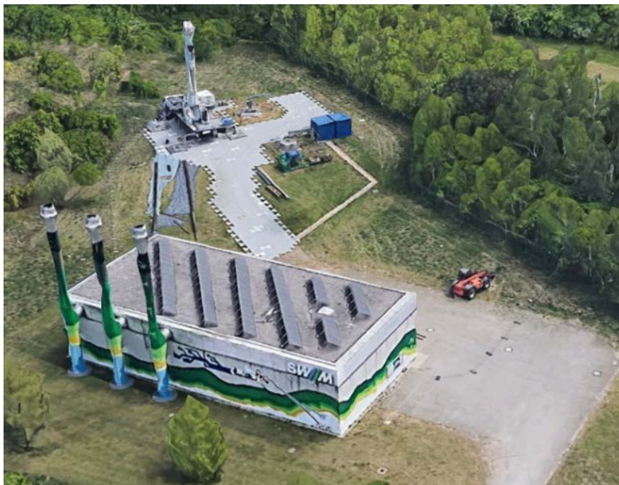
Budynek lokalnej sieci ciepłowniczej w Messestadt Riem. Dach wykorzystany pod zespół kolektorów solarnych.
