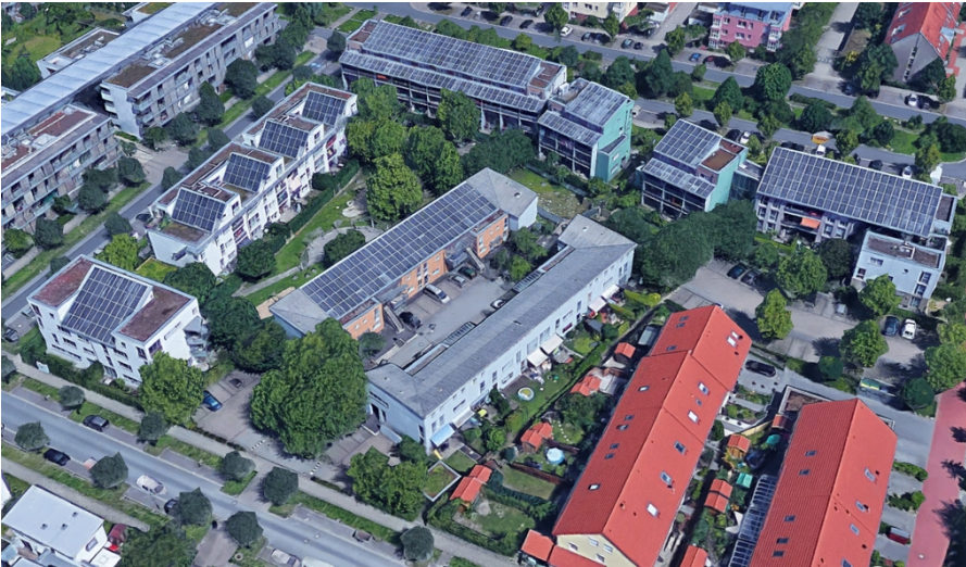
Zespół budynków mieszkalnych wielorodzinnych z instalacją solarną przy ul. Ortskamp
