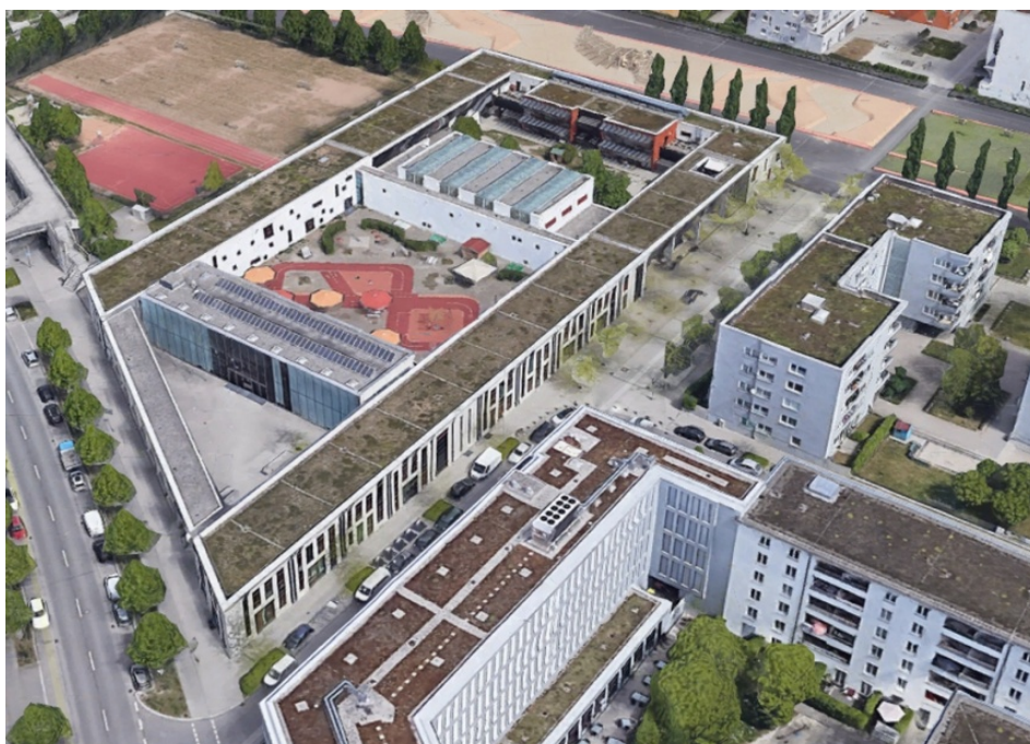
Zespół budynków szkolnych na dachu instalacja solarna i fotowoltaiczna, w tle przestrzeń publiczna, Quartierplatz
