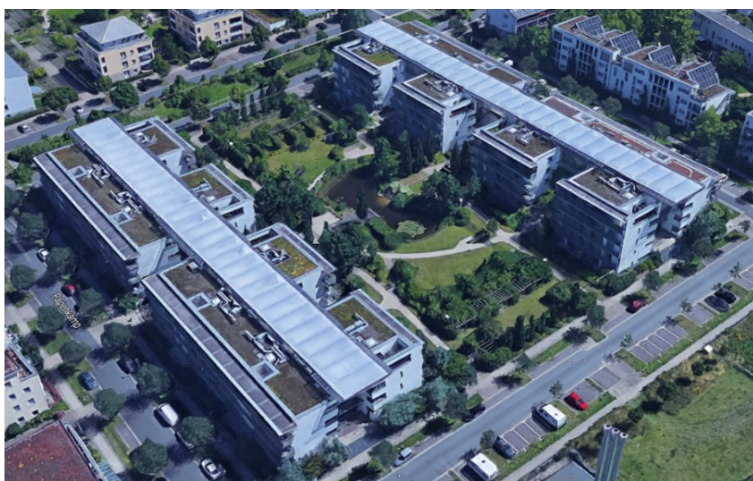
Tereny zielone ze zbiornikiem retencyjnym naturalnym w kwartale zabudowy mieszkaniowej wielorodzinnej przy ul. Ortskamp.
