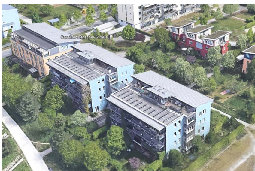
Zespół dwóch budynków wielorodzinnych przy Caroline – Herschel Strasse. Widoczne na dachach instalacje solarne, zorientowane na południe.
