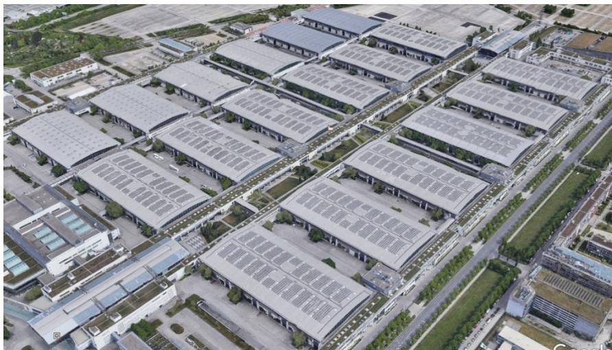
Widok na największą instalację fotowoltaiczną, zamontowaną na dachach budynków Targów w Monachium
