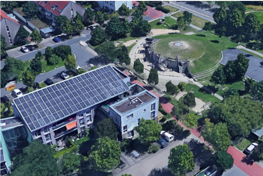
Podziemny zbiornik na ciepłą wodę użytkową przy zespole budynków wielorodzinnych z instalacją solarną przy ul. Ortskamp. Wyraźnie widoczny duży zespół kolektorów słonecznych tworzących dach budynku wielorodzinnego.
