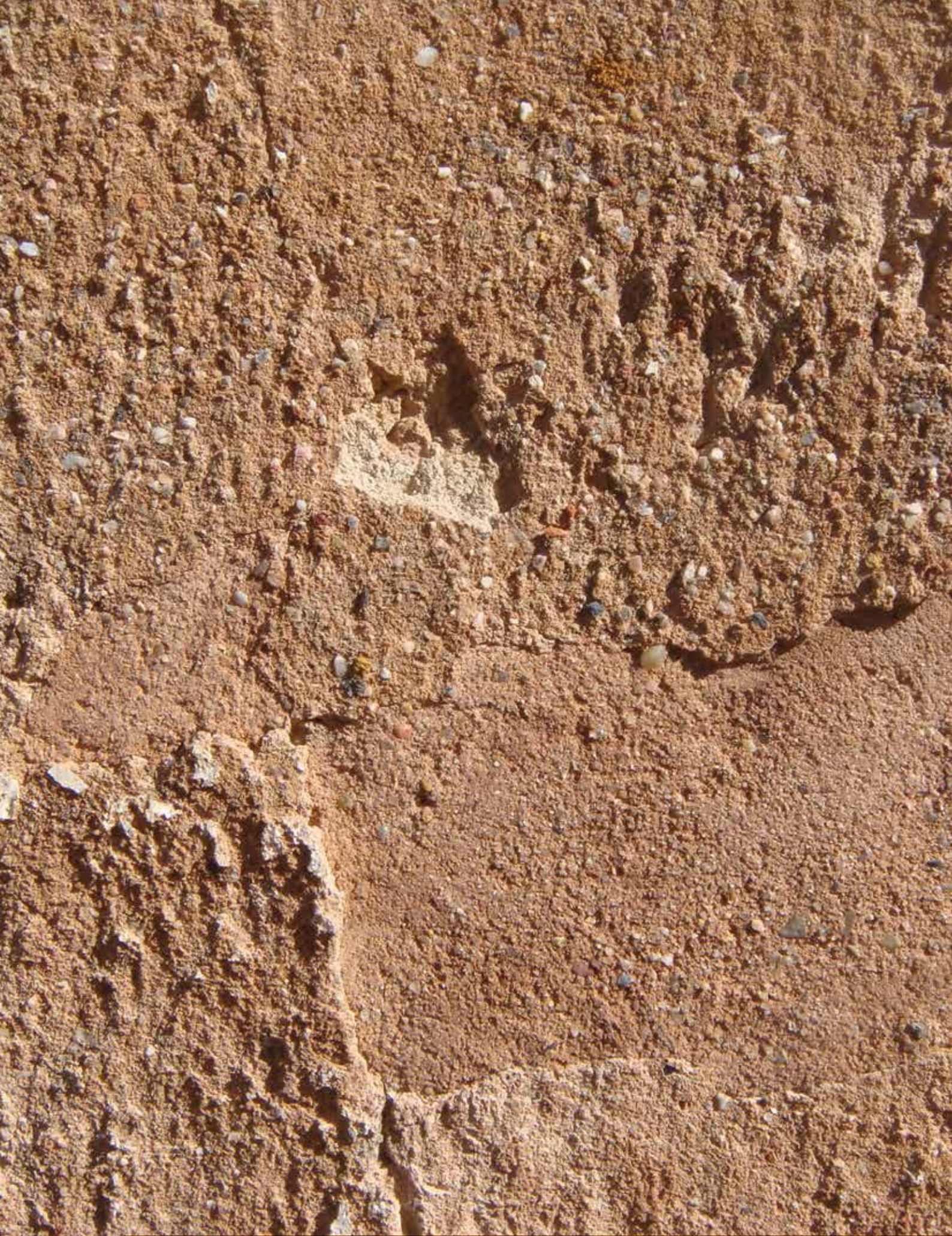
Escuela-horno-barbería de Sesga. Detalle del enlucido original de yeso y reintegraciones hechas con mortero de cal entonado (Todas las fotografías: Fernando Vegas / Camilla Mileto)
