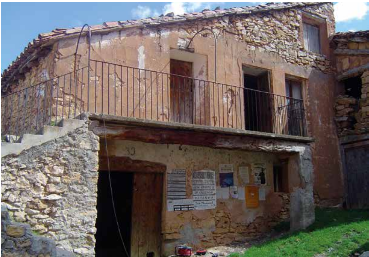
Escuela-horno-barbería de Sesga (Valencia), antes de la restauración
