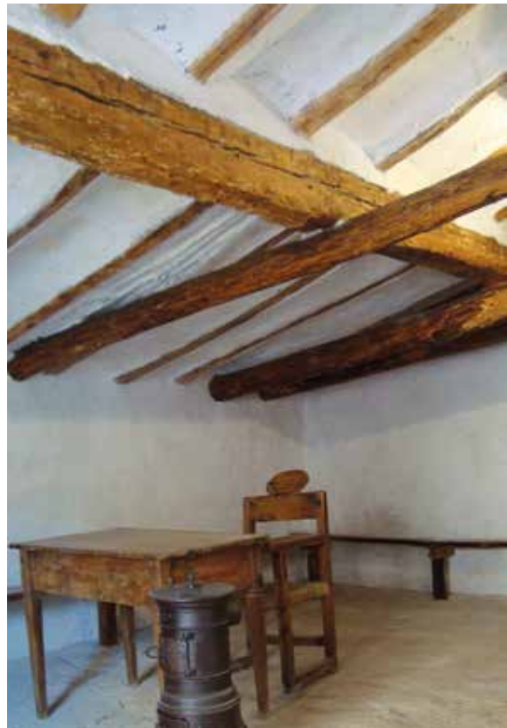
Escuela-horno-barbería de Sesga. Interior de la barbería, antes y después de la restauración
