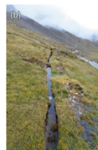
Zanjas de infiltración en Perú: a) Construcción de zanjas. Foto: Comunidad Andina; b) Zanja de infiltración con agua. Foto: Lauren Somers.
