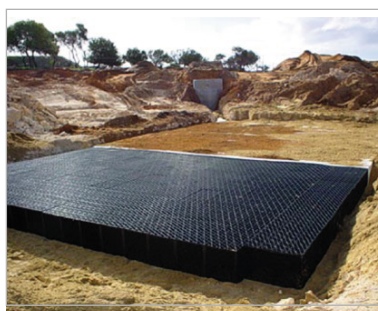
Galerías de infiltración utilizando un sistema de cajas para la cosecha y la recarga de escorrentía urbana en la ciudad de Mandurah, Australia. Fuente: Foto iz: Department of Water, Western Australia (2007); Foto der: Grahame Heal, City of Mandurah (2004); 12
