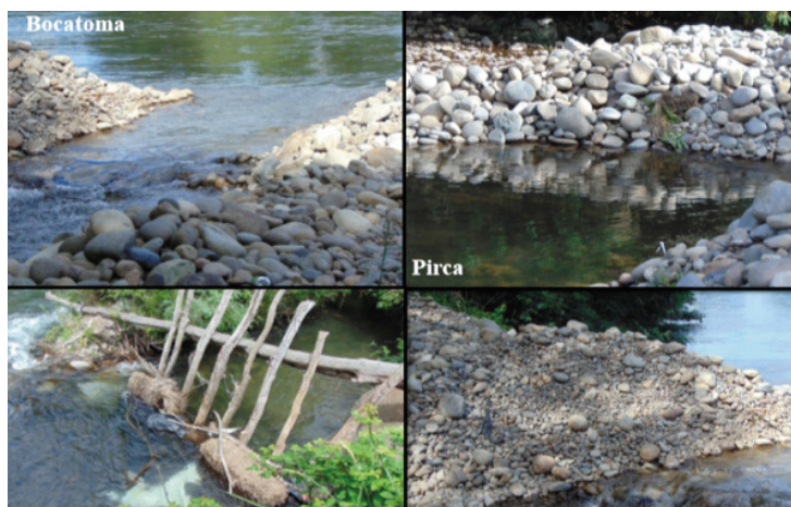
Fotografía de Bocatoma y Pirca en la Región de Ñuble. Fuente: Saldías, J.F. (2019)
