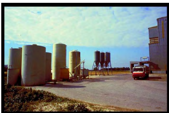
STOCKAGE DE BOUES DANS DES SILOS
