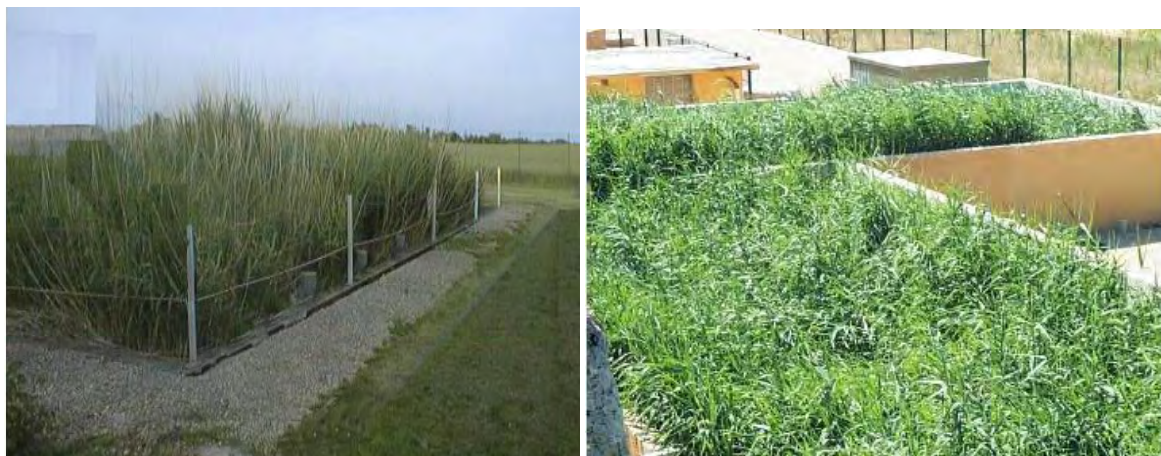
Figure 9 : Lits plantés de roseaux dans le sol (à gauche) et sur béton (à droite)
